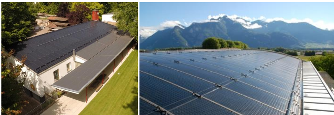
Abbildung 70: Anlagen für die Regeneration von Erdwärmesonden, links: Bachwiesen, ZH, 250 m 2 abs Solardach und En Vésenaye, Voury, 216 m 2 abs , VA (Quelle: Energie Solaire SA)
