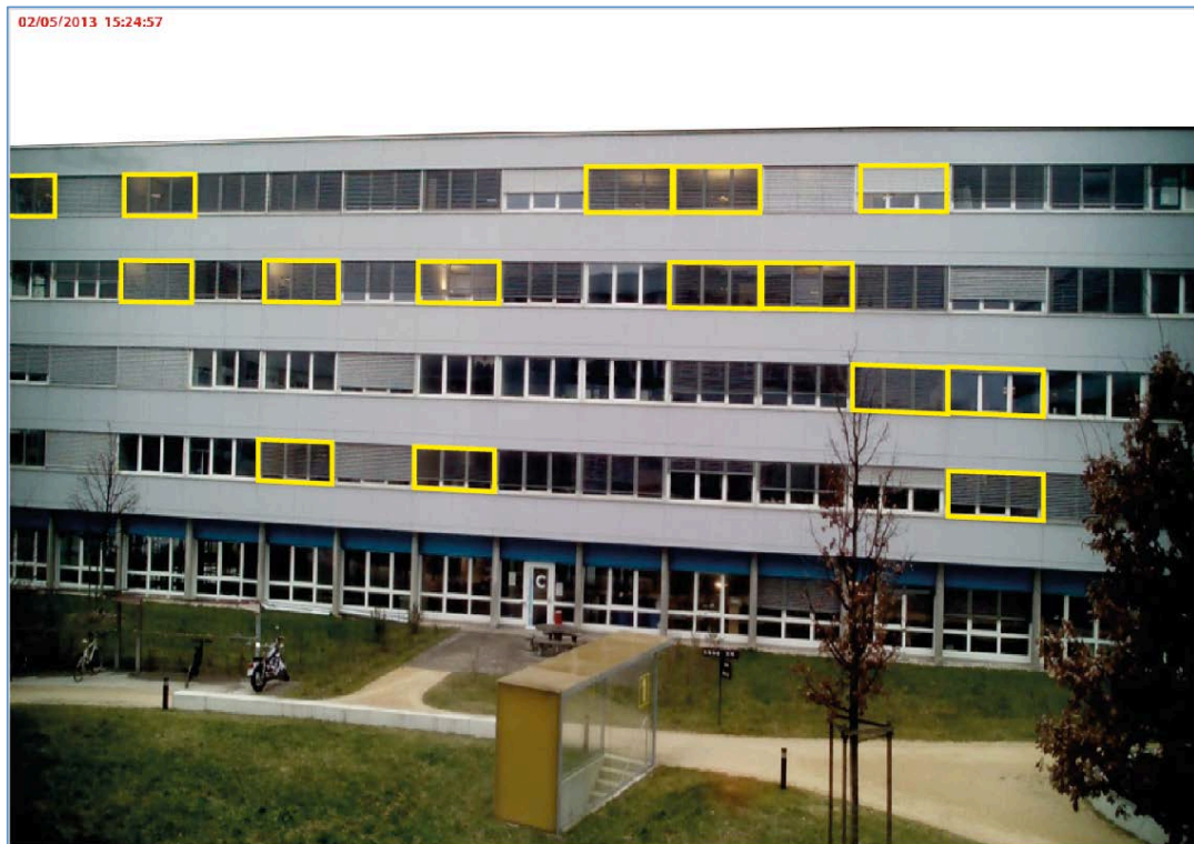
Figure 4 : L'analyse détaillée de cette photo permet d'observer que l'éclairage artificiel est enclenché dans au moins 15 locaux dont les stores ne sont pas en position relevée.
