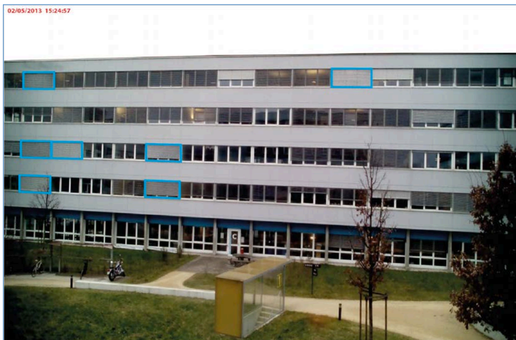
Figure 3 : 7 fenêtres présentent un store baissé entre 90% et 100%, avec les lames fermées.
