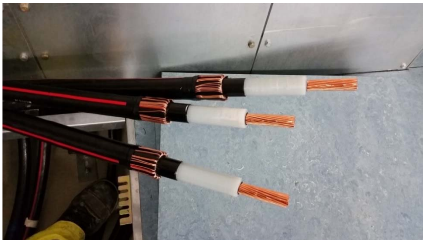
Fig. 41: MS-Kabel Vorbereitung für die Montage des 3M MS-Sensor.
