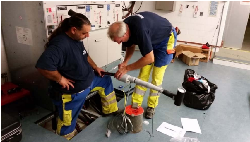
Fig. 42: Kabelendverschluss mit Kombisensor der Firma 3M ist in der Mitte erkennbar.
