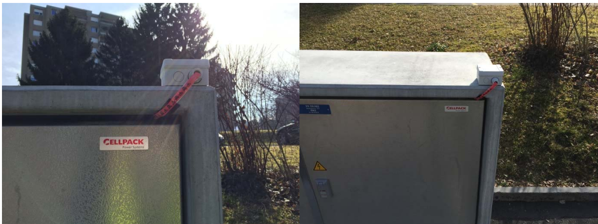
Fig. 46 Alternative und vandalensichere Montage der GPS-Antenne
