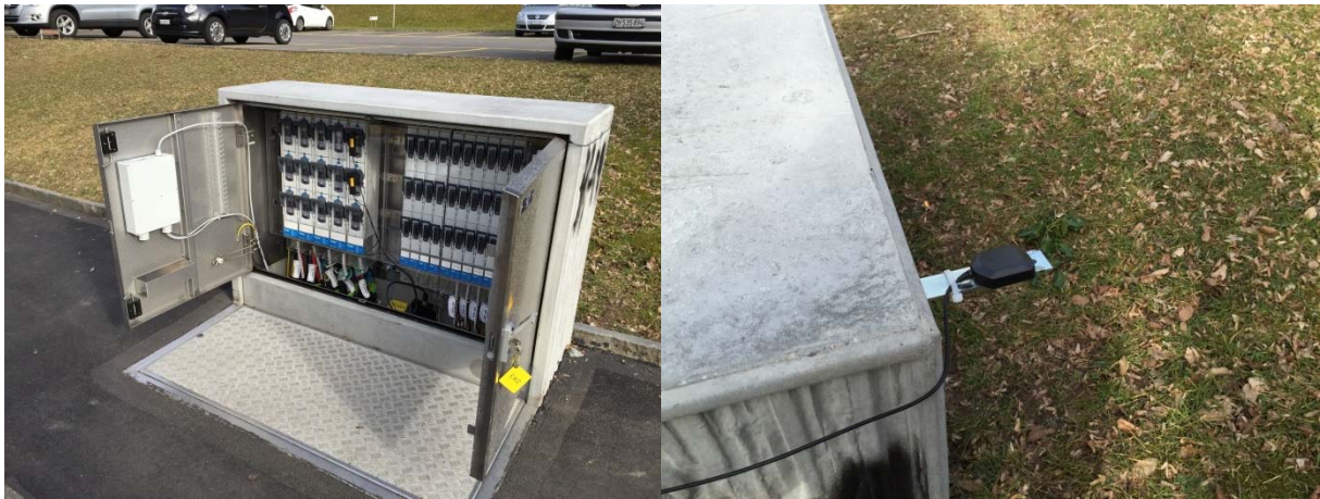
Fig. 45 Montage der GridBox in einer VK
