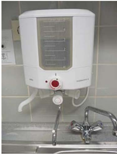
Abbildung 4: drucklose Kochendwassergeräte 5L (links), Kleinspeicher 10L (rechts) (Quelle: Wikipedia.org, Gorenje)
