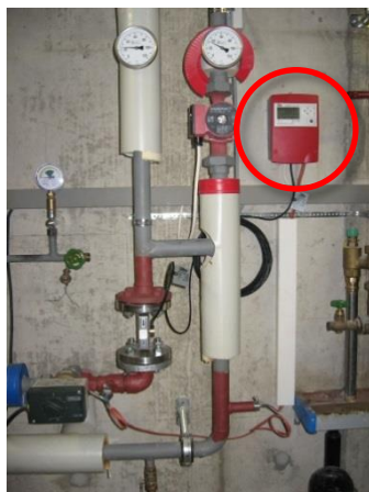
Abbildung 18: Anlage vom Projektpartner Aquametro zur Erfassung der Heizwärmeverbrauchs pro Gebäude: Wärmehesähler (Calec energy master, rote Markierung) und Datenlogger (AMBUS-Net, blaue Markierung), welcher über eine Busverbindung mit den Wärmehesählern verbunden ist.
