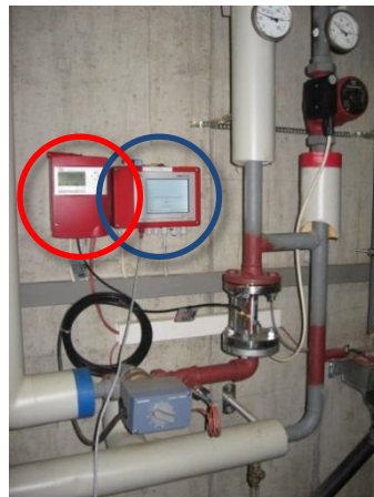
Abbildung 18: Anlage vom Projektpartner Aquametro zur Erfassung der Heizwärmeverbrauchs pro Gebäude: Wärmehesähler (Calec energy master, rote Markierung) und Datenlogger (AMBUS-Net, blaue Markierung), welcher über eine Busverbindung mit den Wärmehesählern verbunden ist.
