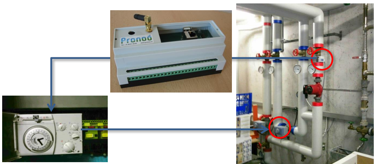
Abbildung 13: Hardwarekomponenten zur Korrektur des Vorlauftemperatursollwertes: Bestehender Siemens-Kompaktregler RVP 210 (links); EcoGateway (2. Generation) von Pronoó GmbH (mitte); bestehende Hydraulikgruppe mit Vorlauftemperaturfühler [Sensor] und Mischventilantrieb [Aktor] (rechts)
