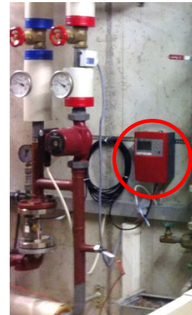
Abbildung 18: Anlage vom Projektpartner Aquametro zur Erfassung der Heizwärmeverbrauchs pro Gebäude: Wärmehesähler (Calec energy master, rote Markierung) und Datenlogger (AMBUS-Net, blaue Markierung), welcher über eine Busverbindung mit den Wärmehesählern verbunden ist.
