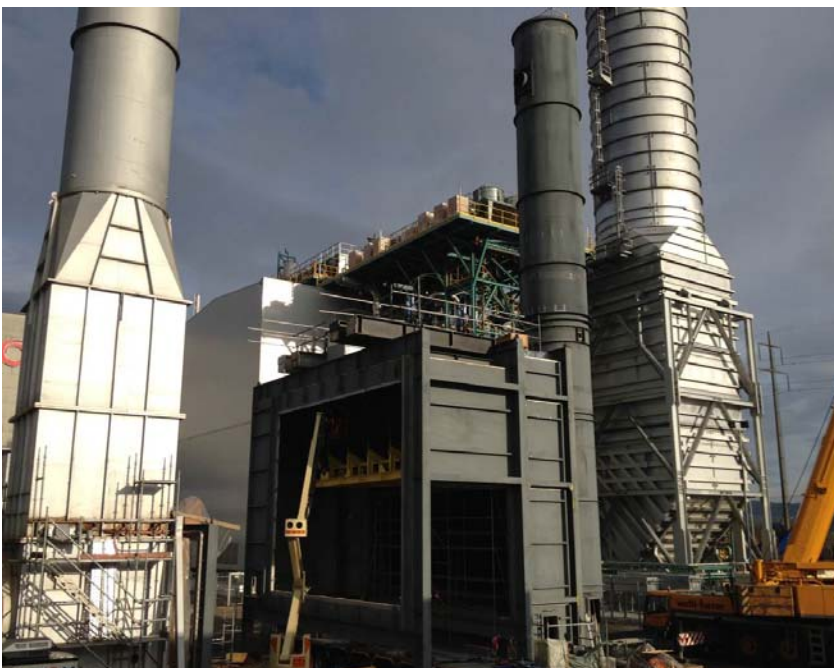
Bild 5: Installation des obersten Verdampfer-Moduls
