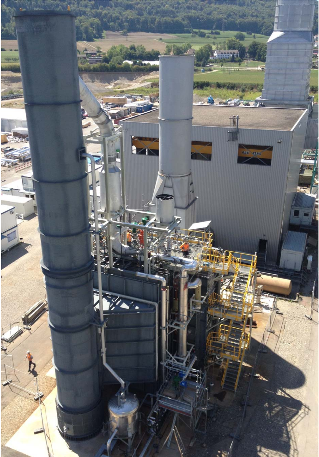
Bild 6: HRSG-Anlage komplett nach Abschluss der Bauphase
