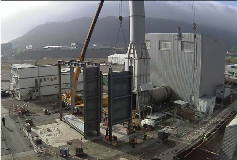
Bild 4: Montage der HRSG-Struktur
