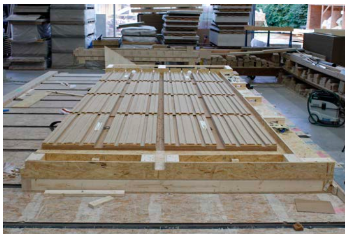
Abb. 7 Fertige Unterkonstruktion. Zur Montage der aktiven Schichten vorbereitetes Dachelement.
