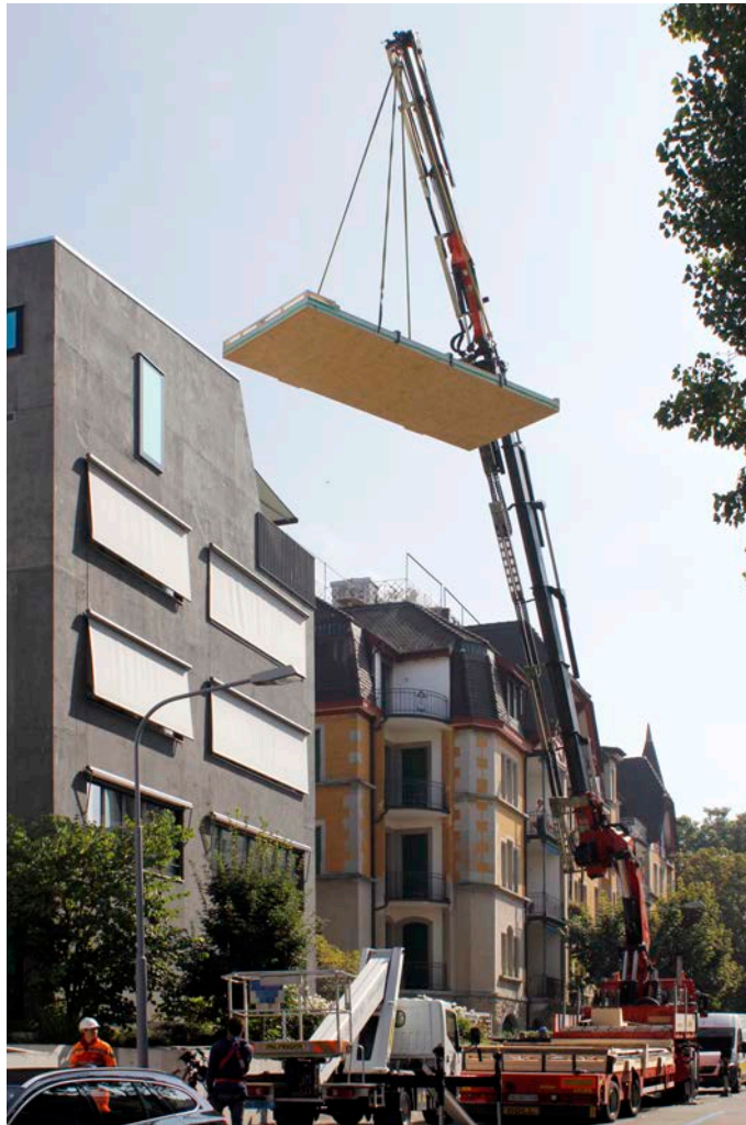
Abb. 9 Montage der vorfabrizierten Elemente. Installation als Testanlage auf dem Mehrfamilienhaus B35 in Zürich.
