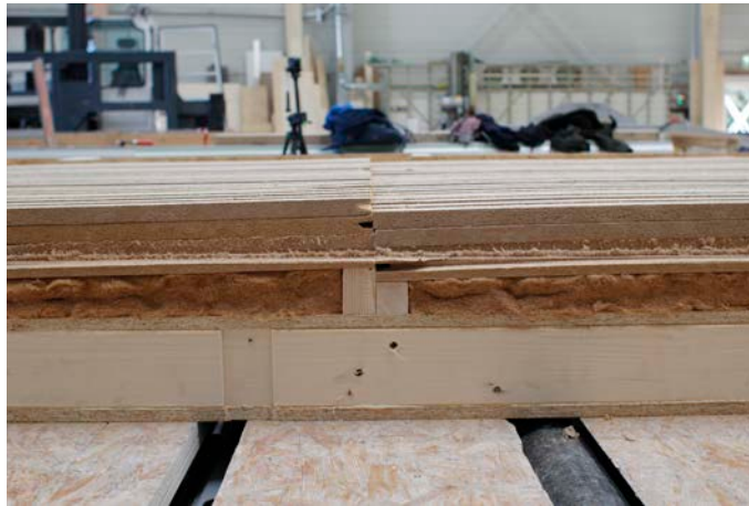
Abb. 6 Aufbau mit Unterkonstruktion und Dämmung. Die Ausgleichshölzer (Bildmitte) garantieren einen genauen Höhenversatz der darüber liegenden Schichten.
