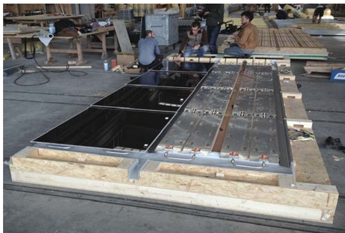
Abb. 8 Montage thermische Absorber und PV Module. Sämtliche hydraulischen Anschlüsse liegen im Bereich der Dachentwässerung.
