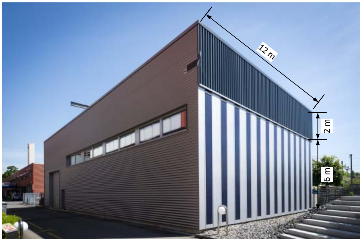
Abbildung 3: In der Versuchsanlage in Horw befindet sich der Luftkollektor im oberen Bereich der Südfassade und versorgt die Halle mit vorgewärmter Aussenluft. Im unteren Teil der Fassade wurden PV-Streifen (Dünnschichtzellen) angebracht, welche als Referenz bei der Benchmark-Analyse dienen. Angegeben sind die Aperturmassen des Luftkollektors.
