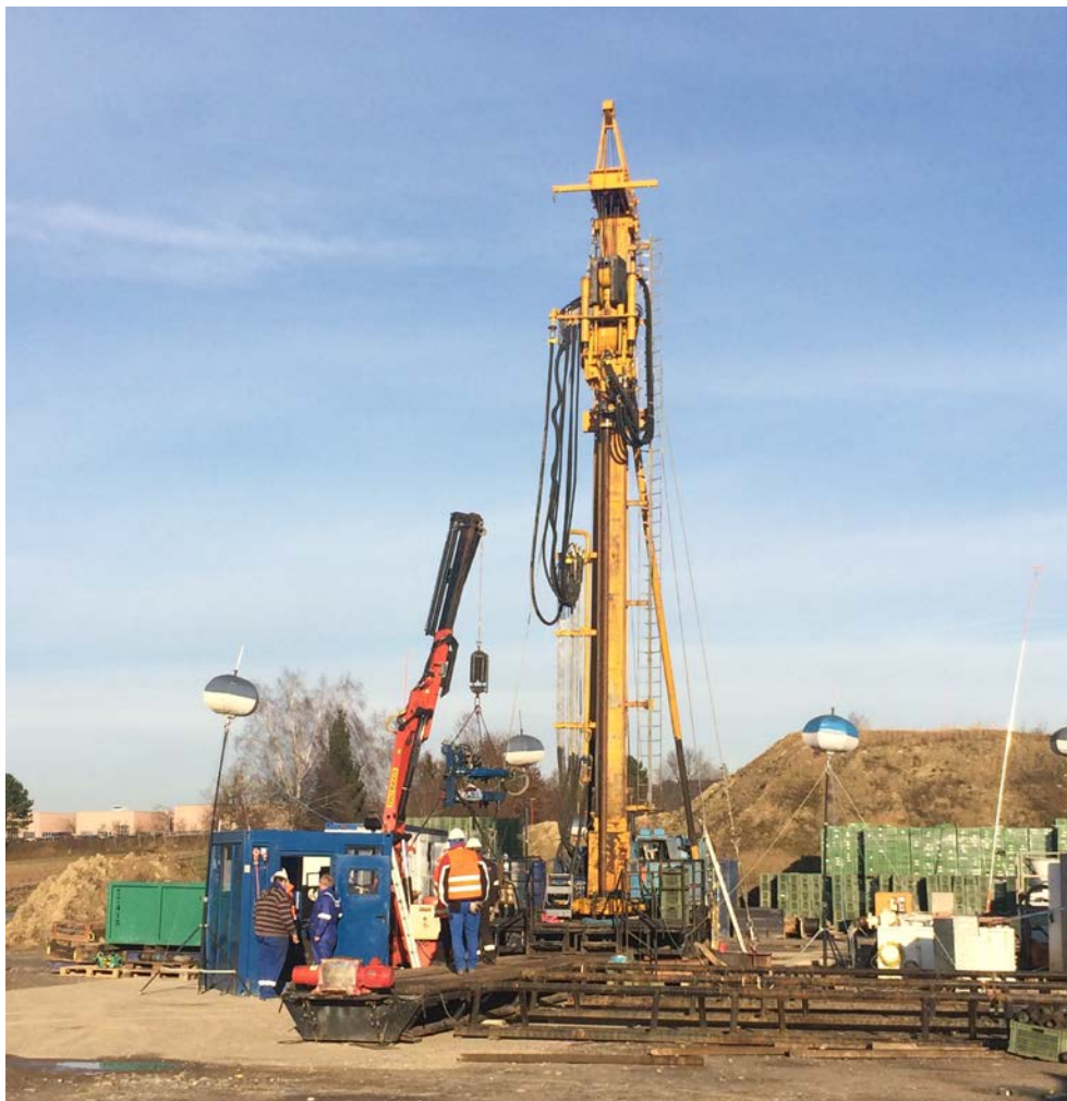
Fig. 3.7: Bohranlage Wirth B5R in Schlattingen
