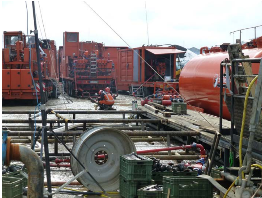
Fig. 3.17: Aufbau der Gerätschaften für die Säuerungsarbeiten SLA-2
