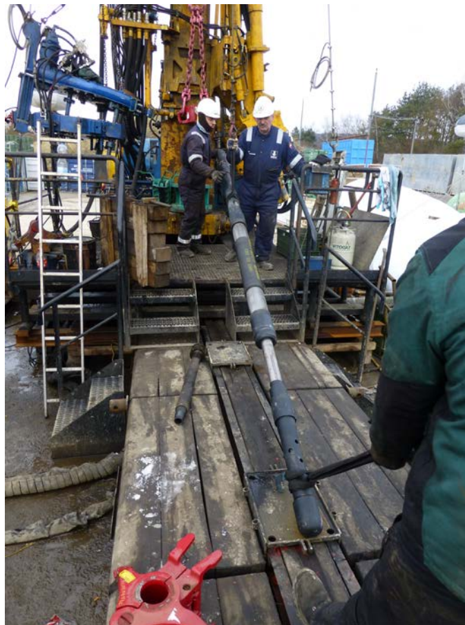
Fig. 3.16: Doppelanker 7"-Casing Packer beim Einbau.
