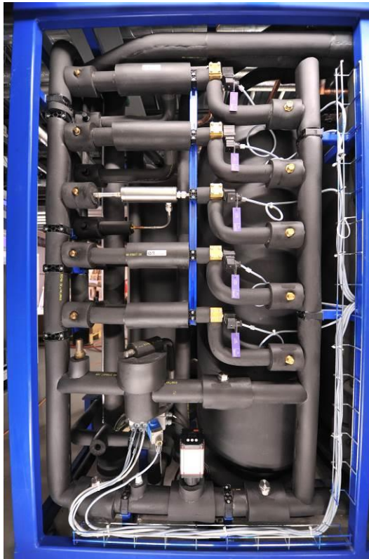
Bild 4: Von Oben; die fünf Ejektoren (ein Ejektor ohne Isolation), mechanisches Hochdruckventil und elektronisches Hochdruckventil
