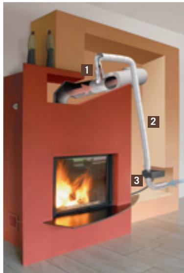
Alle Anlagenkomponenten sind „unterputz“ in die Cheminéeanlage integriert worden und für den Betreiber nur noch über die Frontplatte der Steuereinheit sichtbar. Über eine Revisionstüre muss ein Zugang zum Filtereinsatz ermöglicht werden, denn bei jeder Reinigung der Abgasanlage muss der Filtereinsatz entfernt werden.
