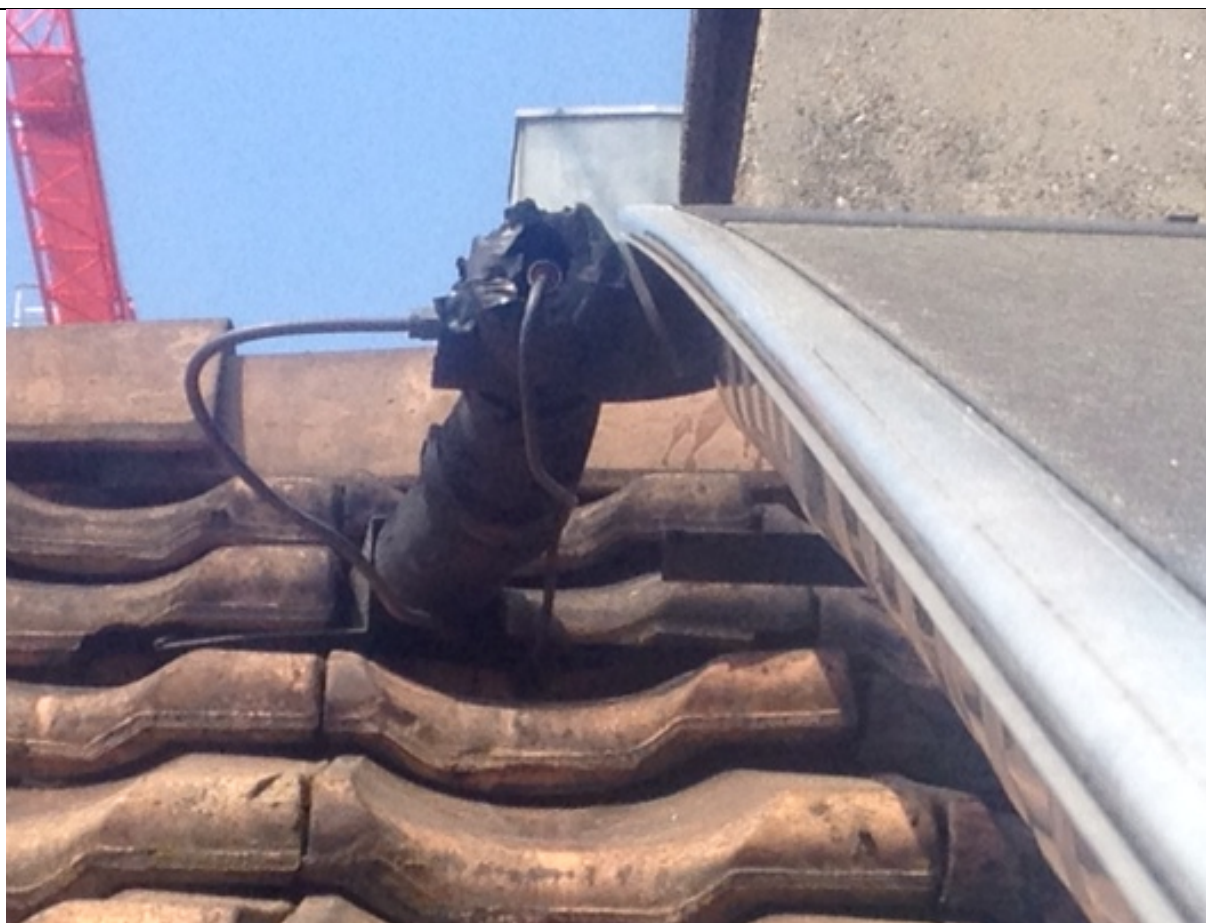
Abb. 10-6: Foto des Kollektoraustritts vom 28. April 2014. Der Temperaturfühler wurde am Kreuzstück auf der falschen Seite montiert.
