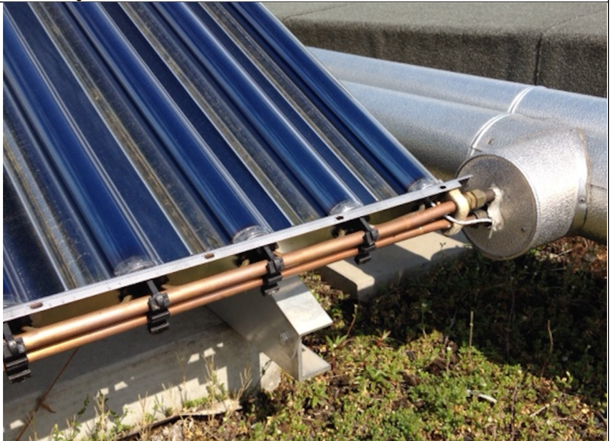
Abb. 7-6: der Kollektorstörungsgrad ist lose unter den Kollektor gelegt. Quelle: Firma LWS Wärmeservice, 28. April 2014
