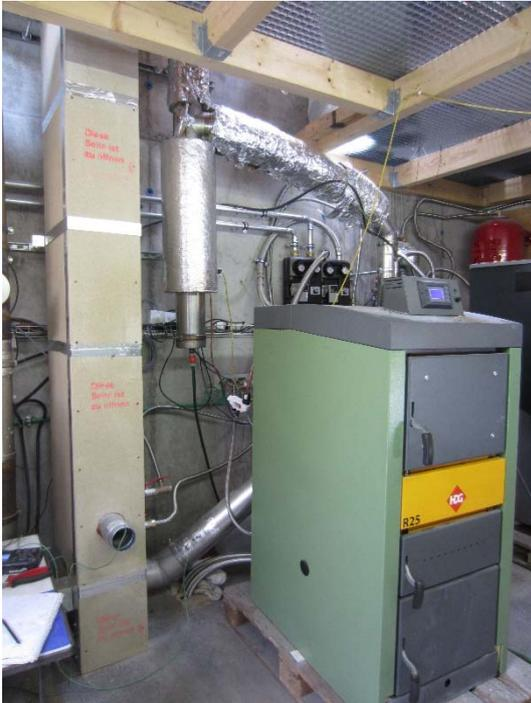
Abbildung 6.7.2.: Stückholzkessel in Plons.
