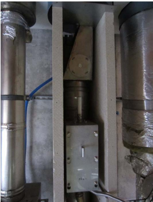
**Abbildung 6.6.3.:** Das obere Isolatorgehäuse und der Übergang zum Abgas-Luft-Wärmetauscher.
