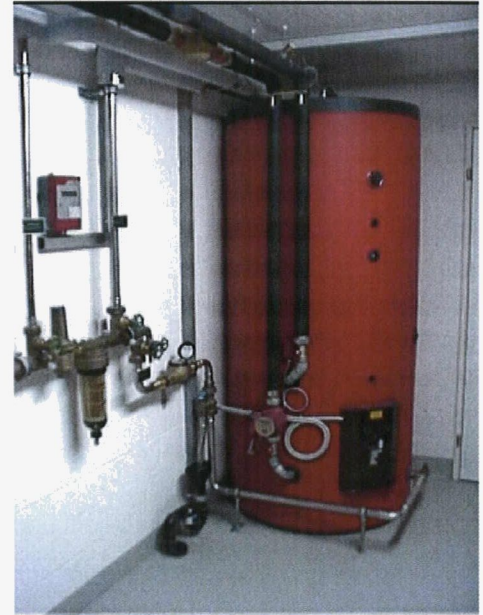
Bild 2.4: Elektroboiler mit Anschlussleitungen für Vorwärmung
