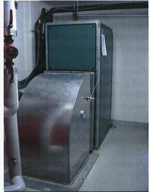
Bild 2.2: Wärmepumpe mit Zuluftkanal
