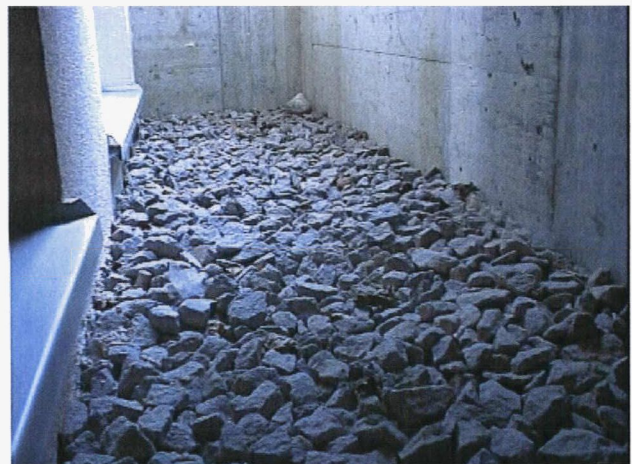
Bild 2.1: Lichtschacht mit Schotterkoffer
