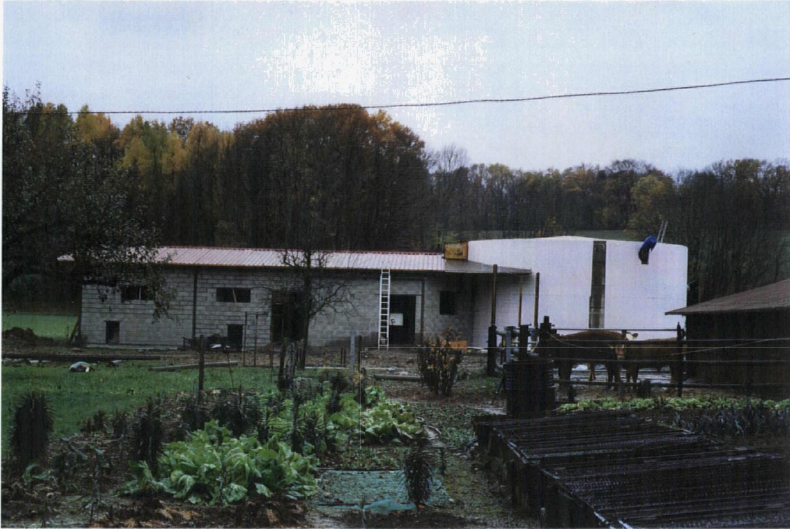
Bild oben: Gesamtansicht der Kompakt-Biogasanlage im Rohbau. Direkt links vom Fermenter ist der Technikraum angegliedert. Daneben wurde ein zusätzlicher Gebäudeteil erstellt.
