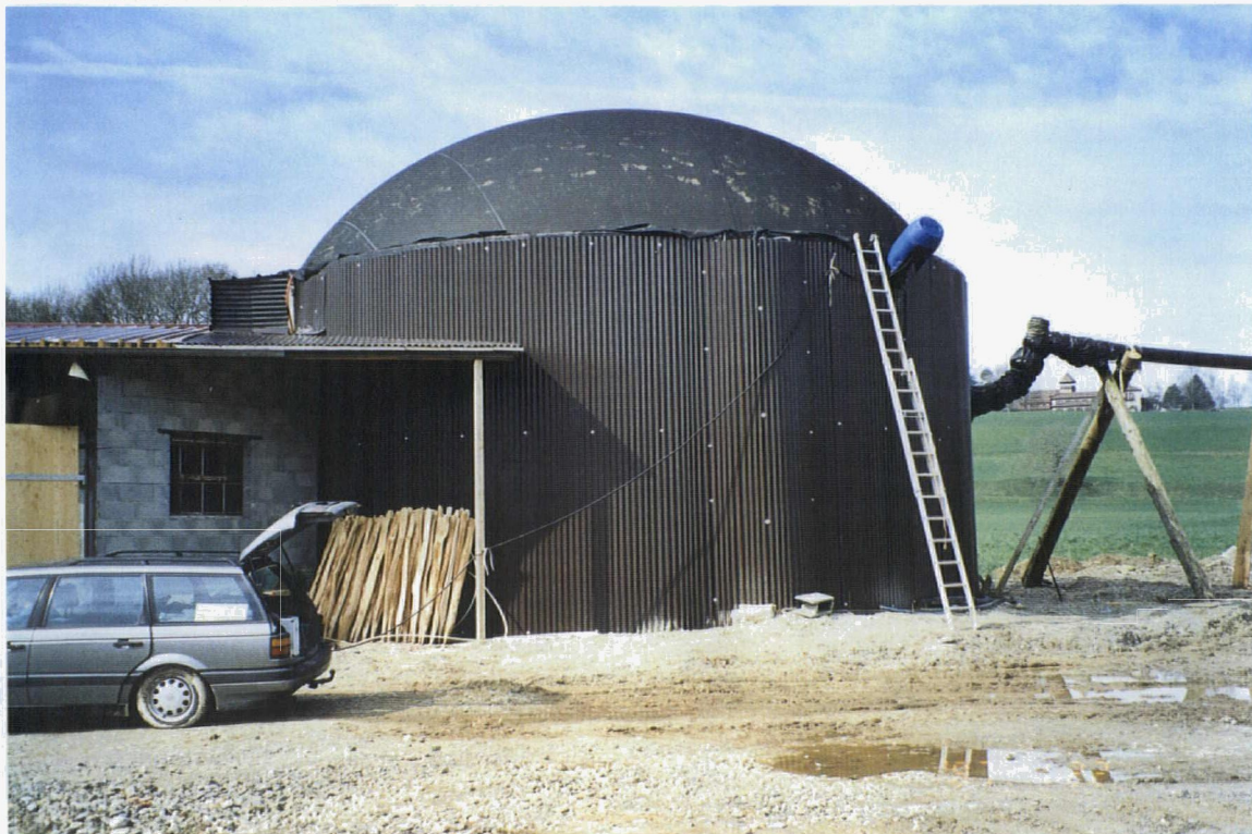
Bild unten: Gesamtansicht der Kompakt-Biogasanlage kurz nach der Inbetriebnahme. Umgebungsarbeiten müssen noch verrichtet werden.
