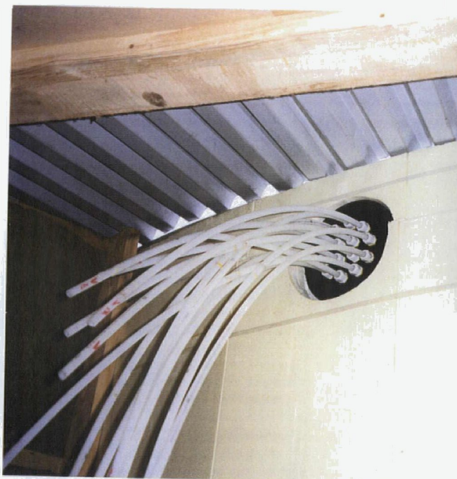
Bild unten: Fermenter mit Durchführung der benötigten Heizkreise
