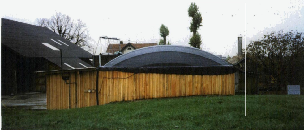
Bild links: Kompakt-Biogasanlage mit Fermenter, Gasspeicher und Technikraum
