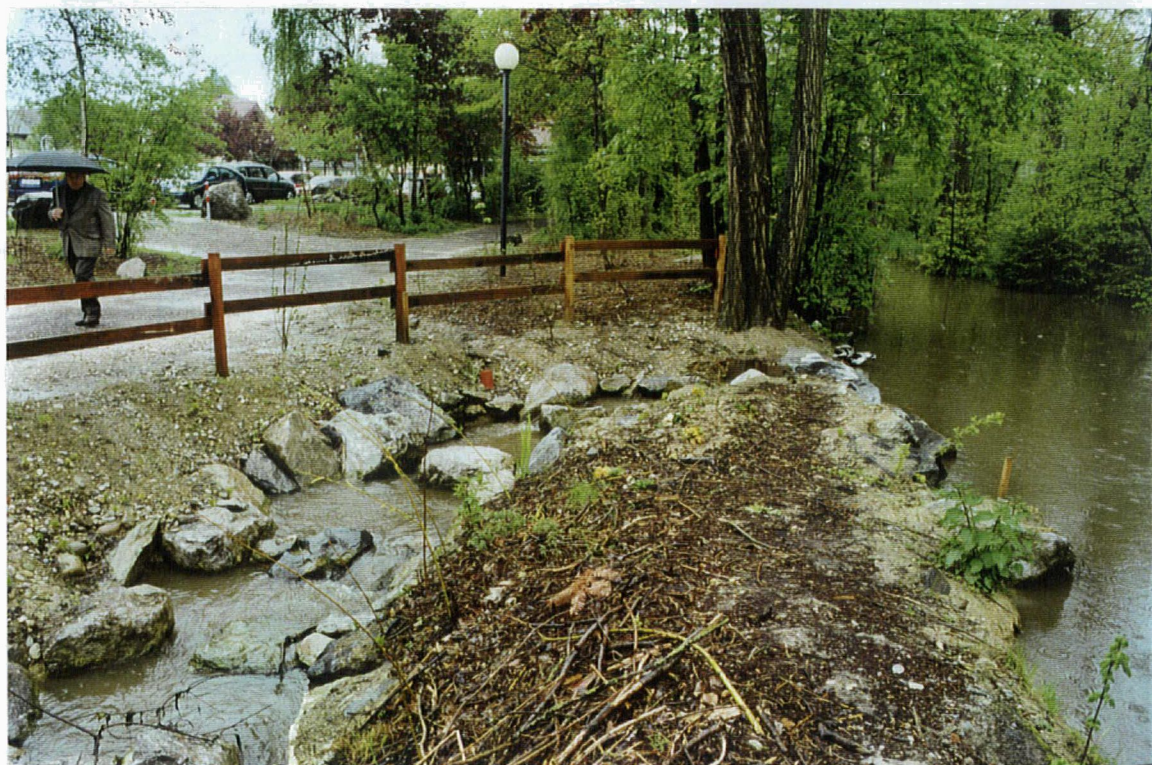
Rauhgerinne oberer Eintritt der Fischtreppe
