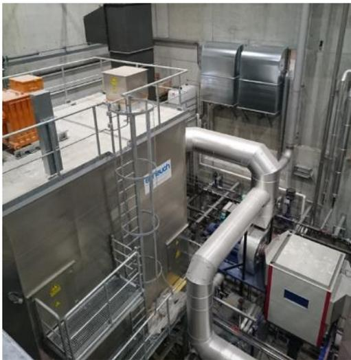
Bild 5 Elektroabscheider (Scheuch GmbH).
