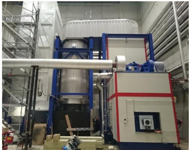
Bild 6 Biomasseanlage mit Feuerung (rechts), Strahlungsteil (mitte) und Konvektionsteil (links).
