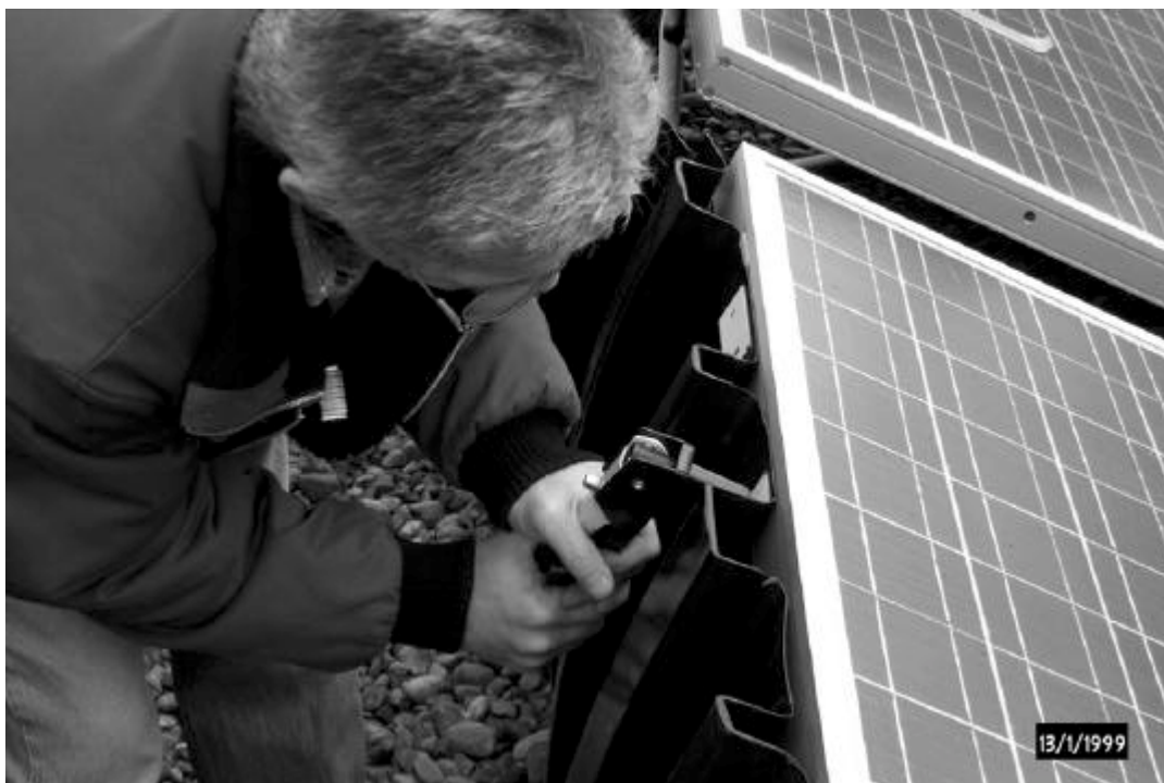
Fig. 4: La fixation est renforcée au moyen de pièces en acier inoxydable protégeant la matière plastique. La fixation est assurée grâce à des rivets pop. La mise à terre (équipotentielle) est assurée grâce aux pièces inox du bas, qui sont un peu plus longues et placées entre deux modules.
