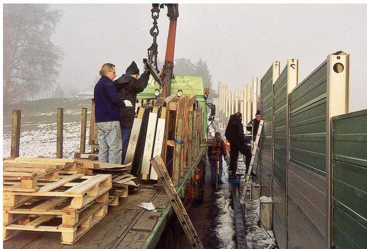
Abb. 14: Die Anlage Brüttsellen bei der Montage. Durch die senkrechte Anordnung war die Montage einfach. Sie dauerte insgesamt ca. 3 Tage wobei jeweils 5 bis 6 Mann im Einsatz waren.
