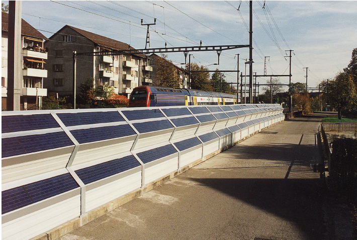
Abb.11 : Die Zick-Zack-Anlage der Arbeitsgemeinschaft Borra/Atlantis an der Bahnlinie Wallisellen - Dübendorf. Die Stahlstützen sind in Zick-Zack-Form geschweisst. Die PV-Module wurden auf Aluminium-Schallschutzkassetten geklebt.
