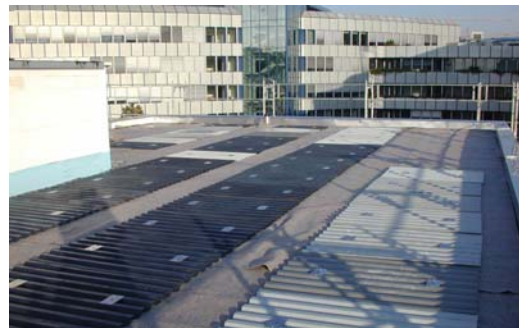
Abbildung 17: Ausgelegte Deltatec®-Platten
