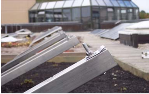
Abbildung 30: Das Modul kann in die Klammer eingehängt werden.
