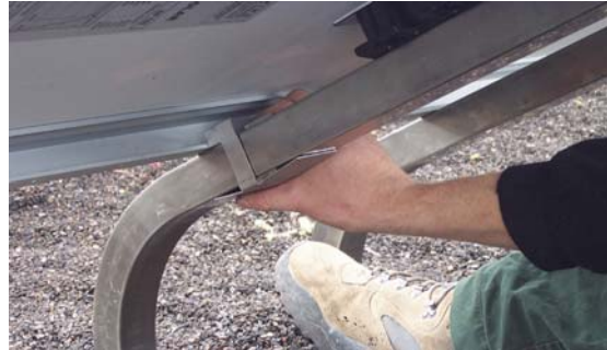
Abbildung 31: Die Haltebügel werden unten aufgeschoben
