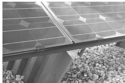
Abbildung 28: Die Lamine werden mit Edelstahlklammern festgehalten.
