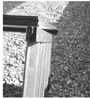
Abbildung 26: Die Lamine werden mit Solface-Profilen verbunden, die ihrerseits mit Hilfe von U-Profilen auf den Deltatec®-Platten fixiert sind.
