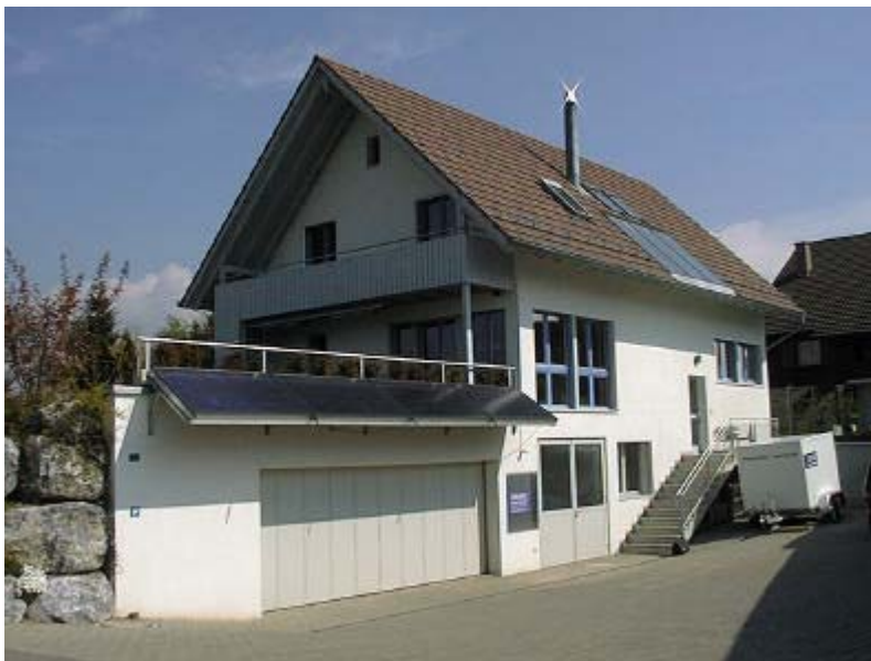
Abbildung 5: Kundenspezifische Lösung mit 4 Modulen Solarstrom über dem Garagentor. Diese Anlage hat keinen direkten Bezug zur solarthermischen Anlage im Hausdach.
