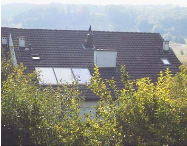
Abbildung 4: Anlage C mit zwei Modulen Solarwärme und einem Modul Solarstrom.
