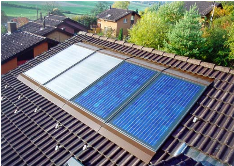
Abbildung 3: Anlage B mit je zwei Modulen Solarthermie und Solarstrom.
