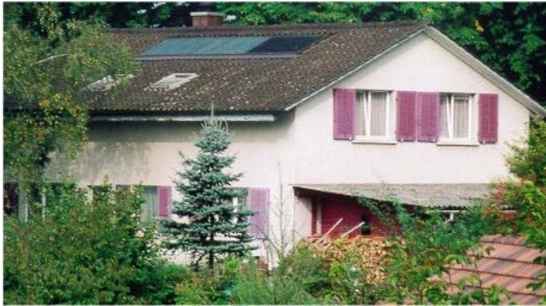
Abbildung 2: Anlage A mit zwei thermischen Kollektoren und einem Modul Solarstrom 240W.
