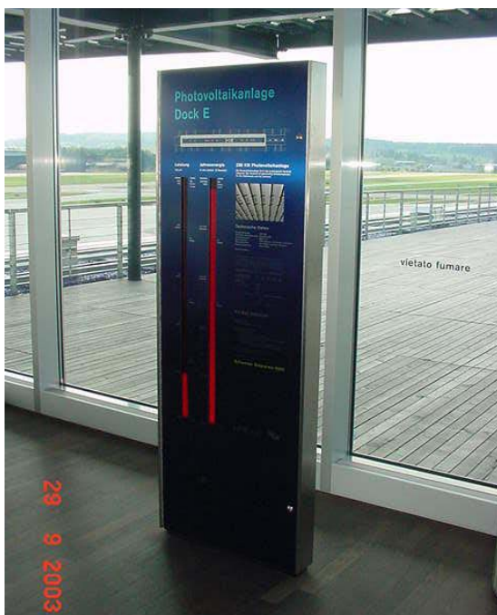
Bild 12: Eine Anzeigetafel zeigt die momentane Leistung und den jährlichen Ertrag der Solaranlage und macht die Besucher des Zuschauerbereiches auf die PV-Anlage aufmerksam
