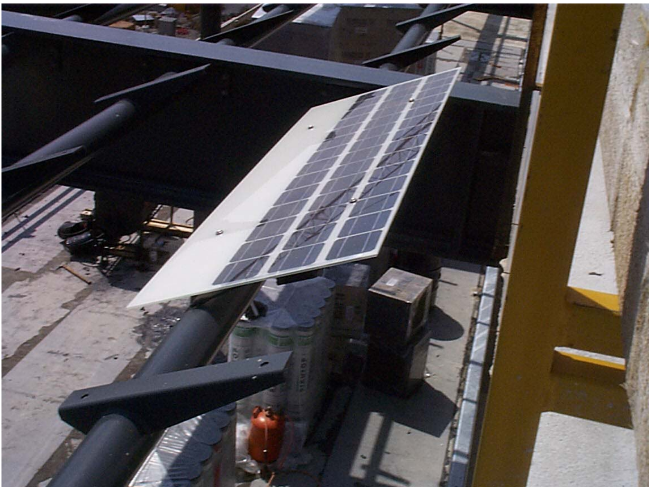
Bild 3: Detailansicht einer Solarlamelle und der Unterkonstruktion
