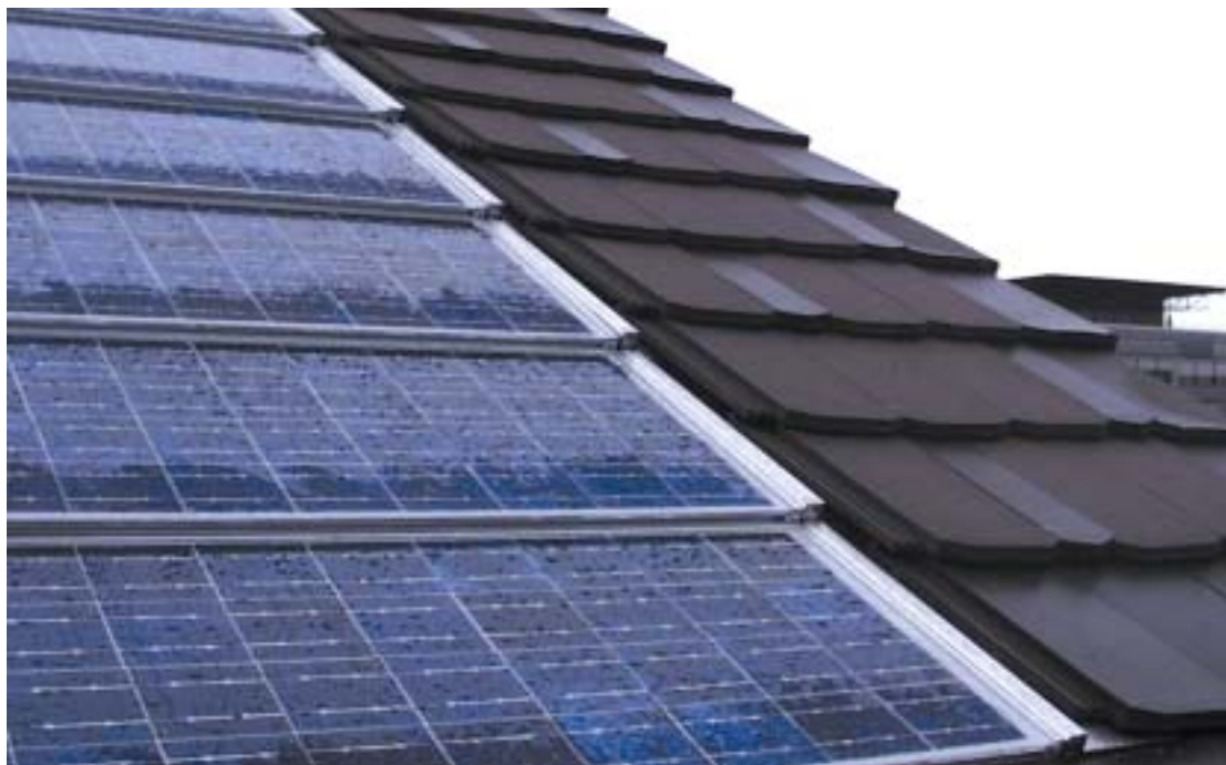
Figure 66 : Toiture inclinée avec intégration des éléments SOLRIF
