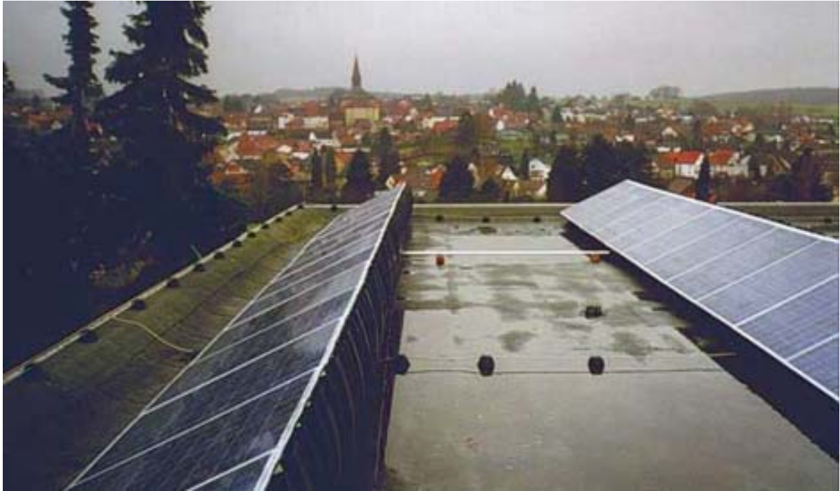
PV array on a flat Heidelberg (Deutschland), 5 kW, 1999
