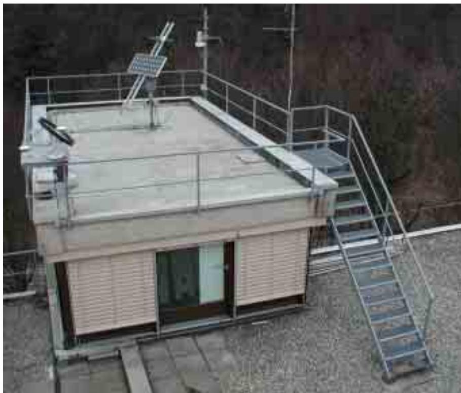
Figura 10: Tetto predisposto per il sistema di posizionamento automatico dei moduli PV alla normale dell'irraggiamento solare (Sun Tracker).
