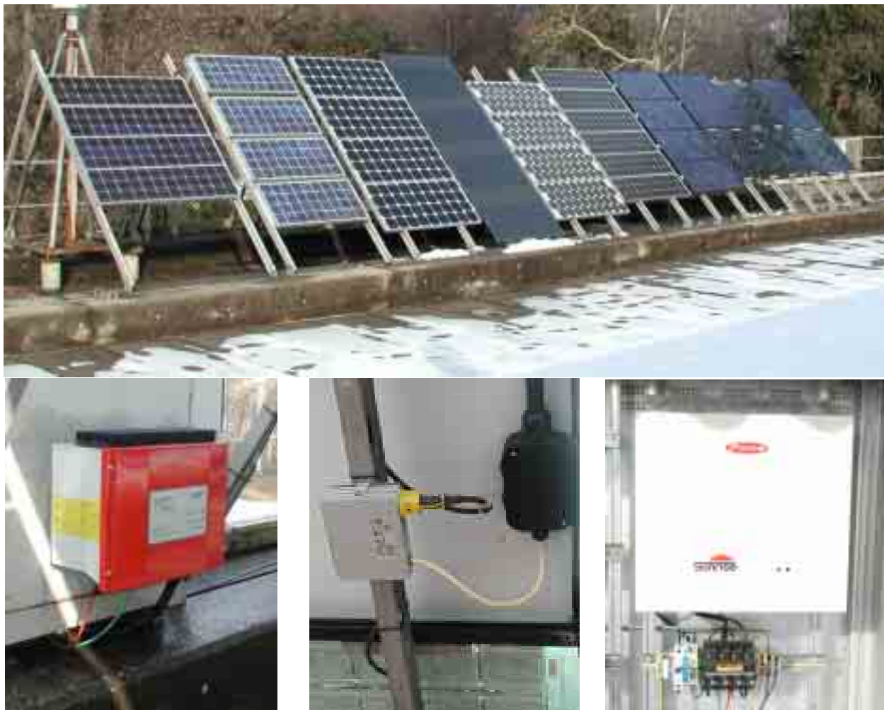
Figura 74: Stand di impianti allacciati alla rete, con ondatore DC/AC monofase (postazione 1)
