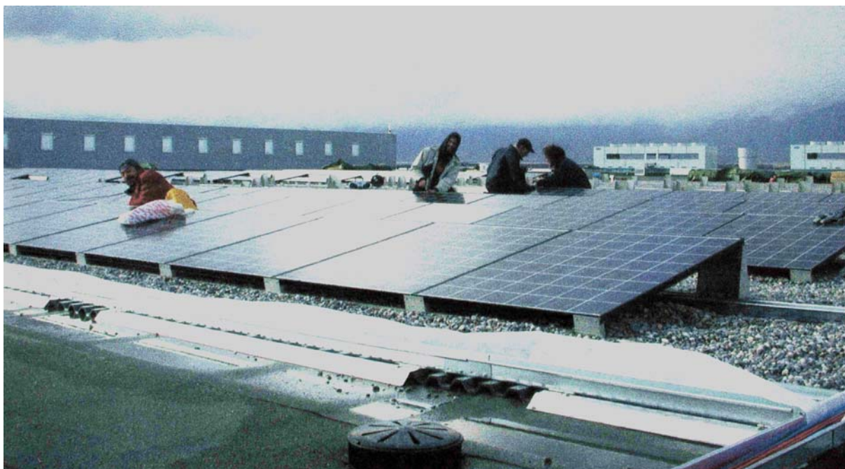
Le montage de l'installation, avec la structure nécessaire pour la pose des panneaux sur la toiture
