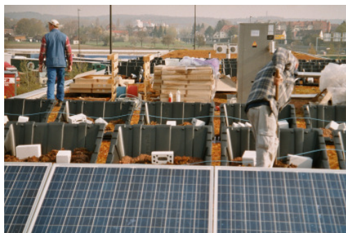
Die Verwendung von Kunststoffwannen hat eine einfache, schnelle Montage möglich gemacht.
