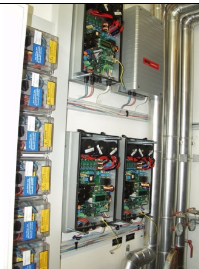
Im Technikraum der Zollanlage konnten sämtliche Wechselrichter installiert werden.
