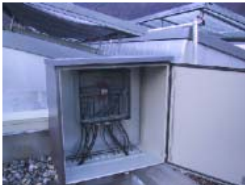
Abb. 12: AC-Klemmekasten
