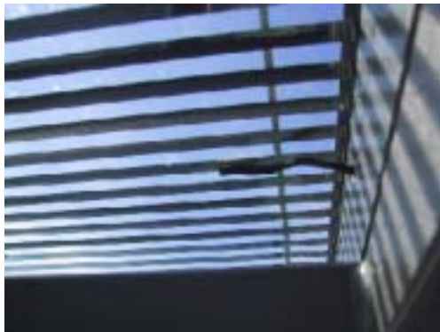
Abb. 11: Aktiv- Modultemperaturfühler
