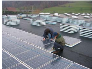
Zusammensetzen der Solar- dachplatten
