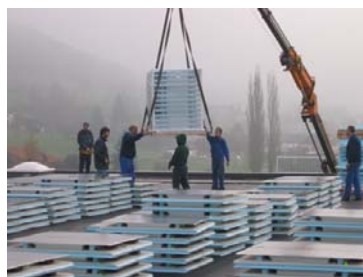
Ablad der Module auf Dach Hochregallager
