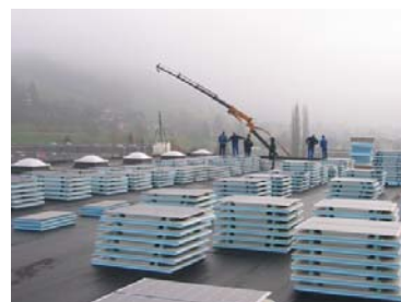
Verteilte Modulstapel auf dem Dach
