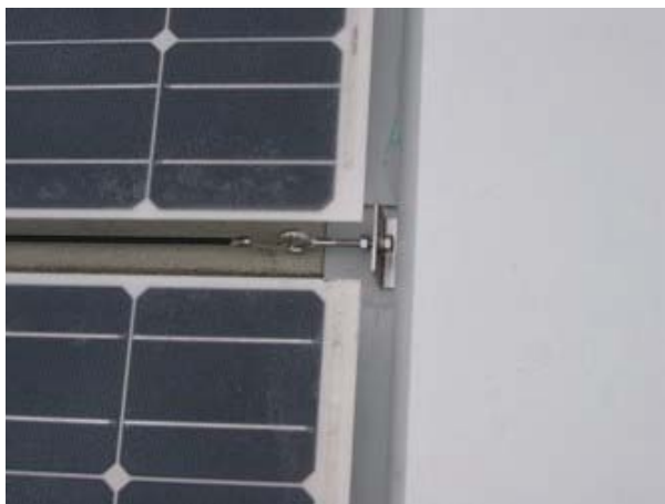
Bild 6: Sicherung mit Drahtseil
