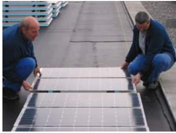
Zusammensetzen der Solar- dachplatten
