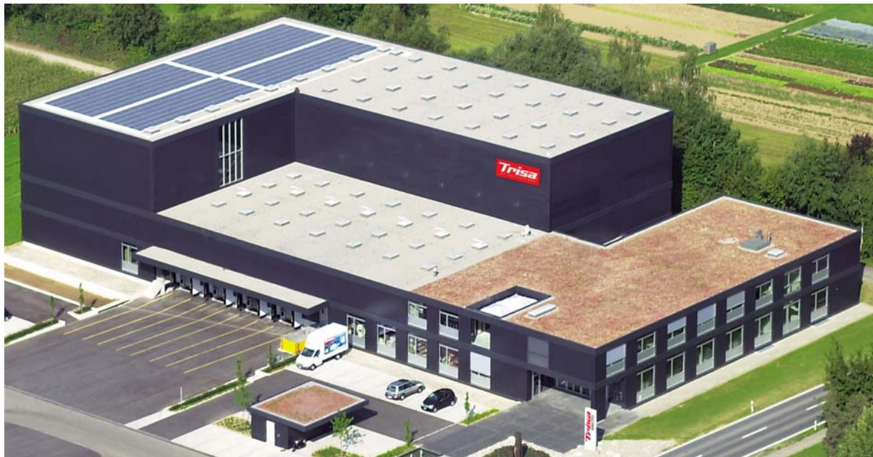
Luftaufnahme Trisa Electro AG mit integrierter Photovoltaikanlage
