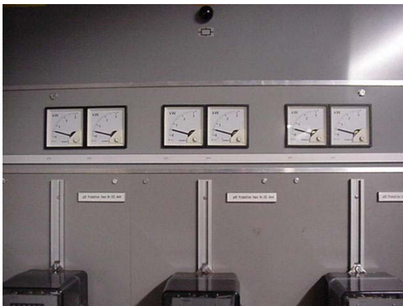
Bild 10 Schneller Überblick mit nebeneinander angeordneten Leistungsmessgeräten.
