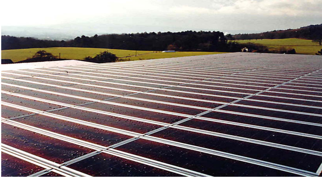
Bild 2 Südausrichtung mit vollflächigem PV Dach (Eurodach).
