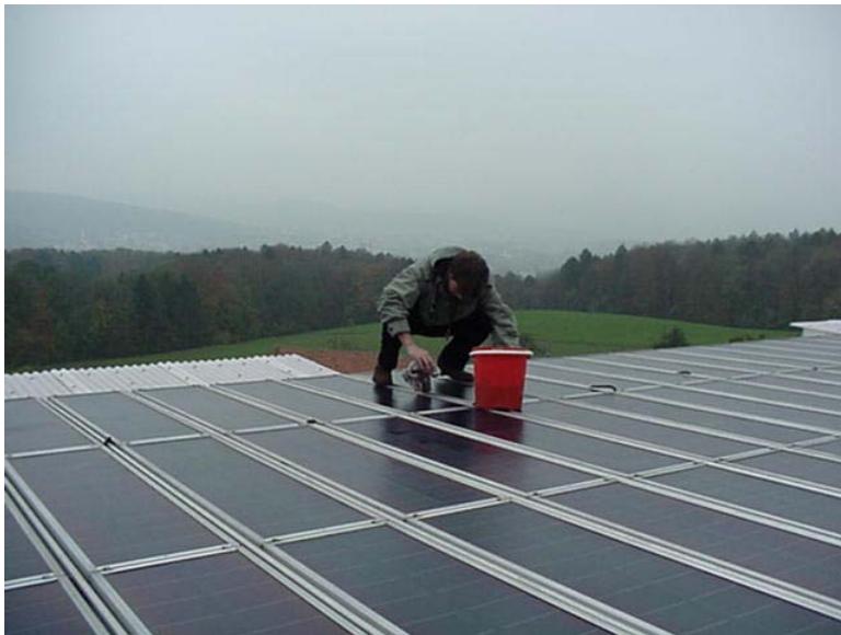
Bild 6 Die Schmutzschicht lässt sich leicht entfernen, es ergibt einen Mehrertrag von 5 und 10% in den gemessenen Novembertagen.
