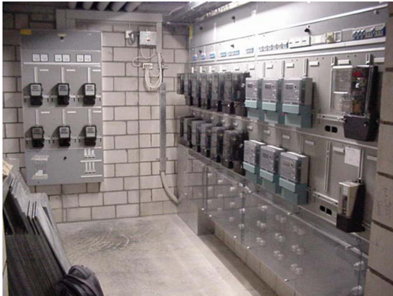
Bild 9 Elektro-Zählerraum mit PV-, Haushalt und WP-Bezugs- und Rücklieferzähler.
