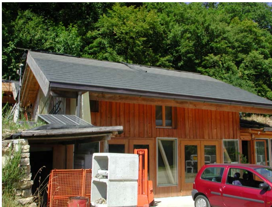
Figure 1 - vue générale de la toiture Sunslates TM
