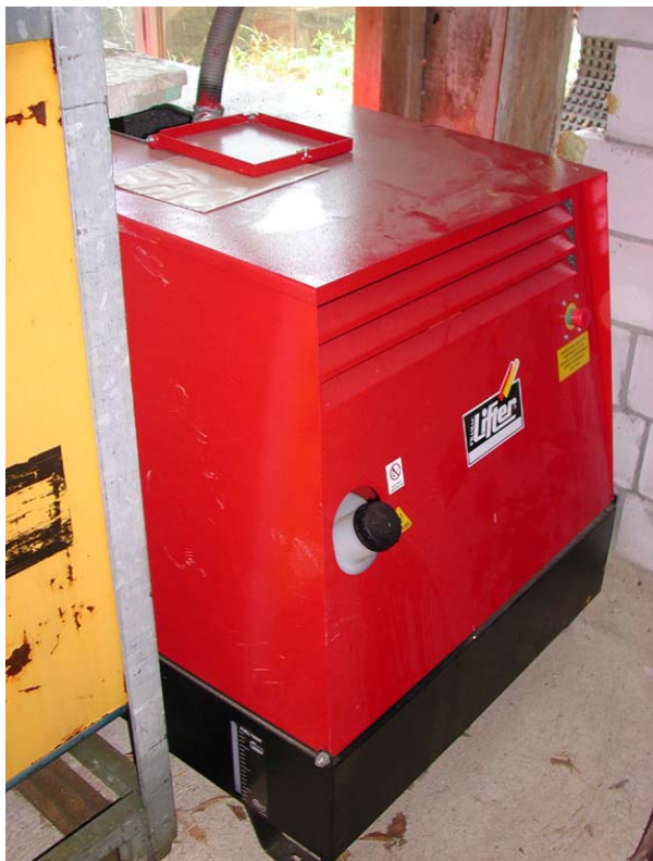
Figure 6 - Le groupe électrogène a été équipé par Solstis d'un compteur d'énergie pour en connaître la production avec précision.
