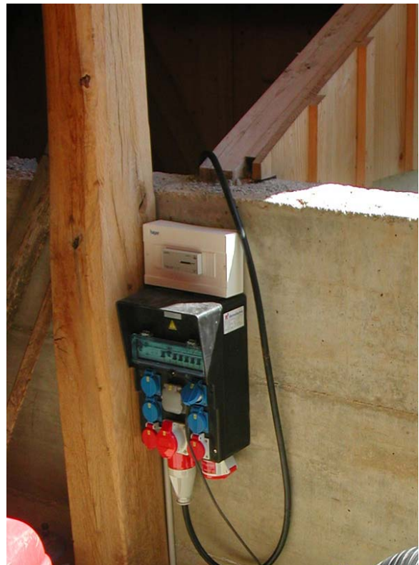
Figure 6 - Le groupe électrogène a été équipé par Solstis d'un compteur d'énergie pour en connaître la production avec précision.
