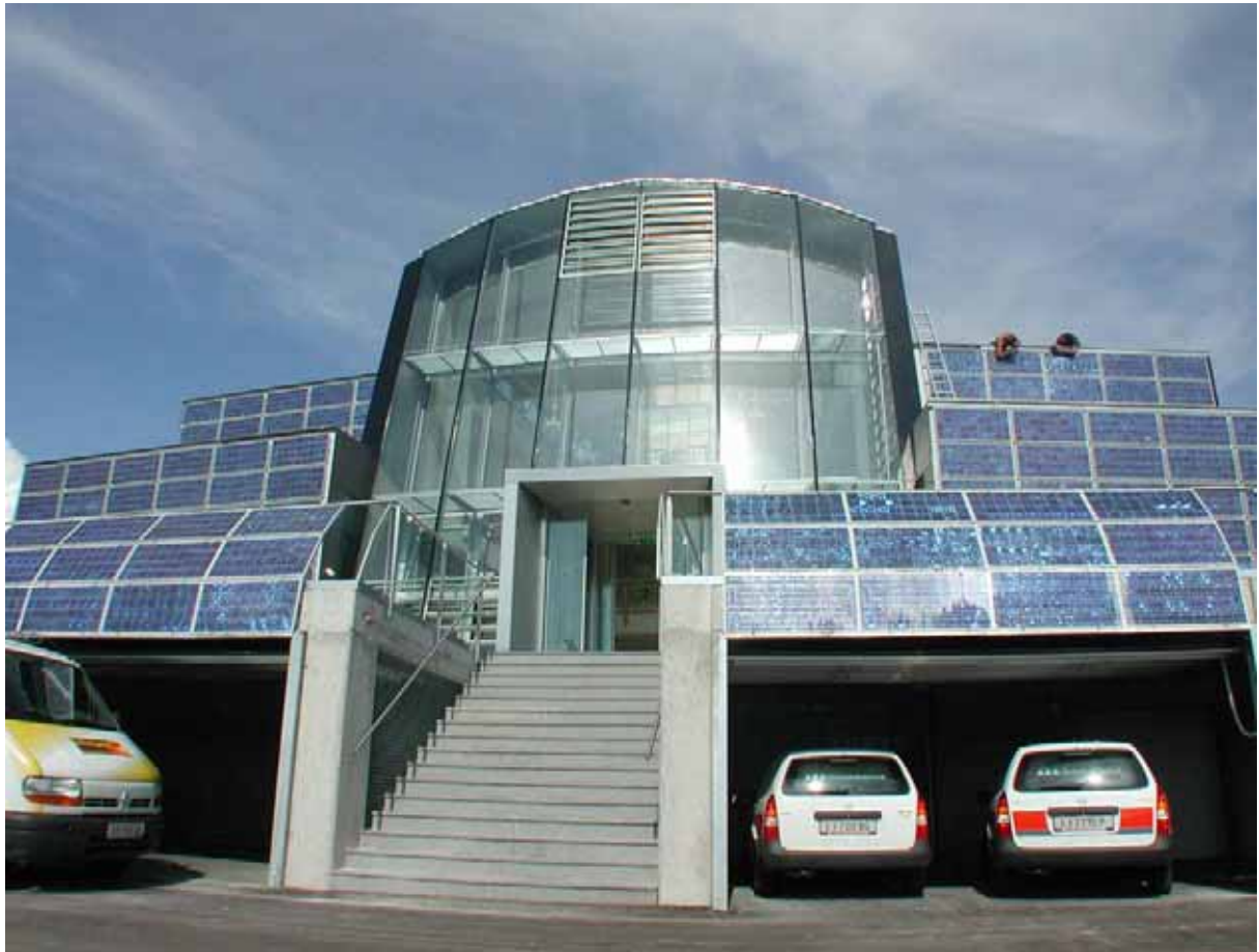
Abb. 26 Dank Niedrigenergiebauweise und aktivsolaren Komponenten energieautarkes Marketinginstitut in Gutau bei Linz – sogar die Garagentoren sind bestückt mit Solarmodulen
