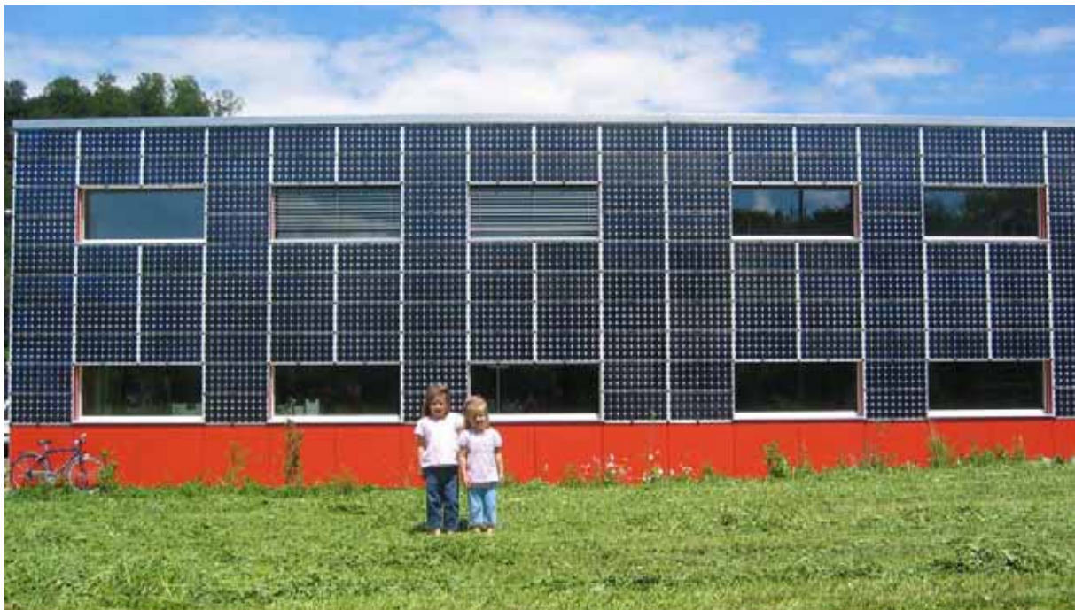
Abb. 5 PV-Module als Fassadenverkleidung machen ein Haus zum „Kraftwerk“
