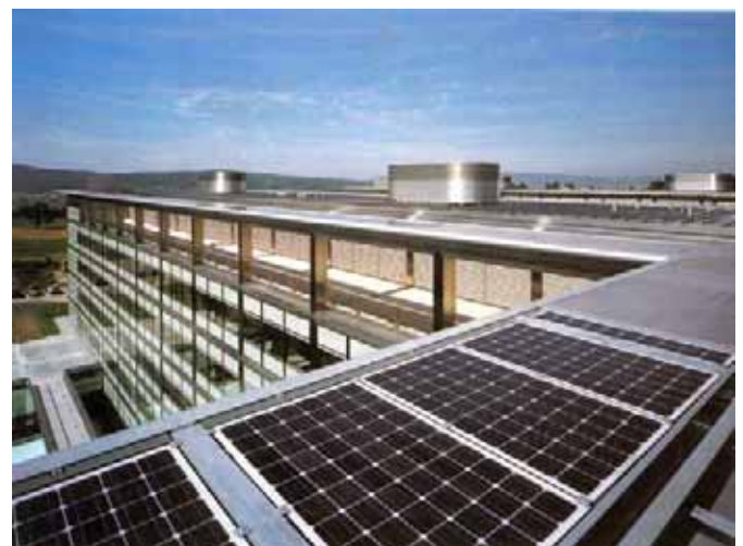
ETH Hönggerberg, HCI, Zürich Bild: Electrowatt Infra AG
