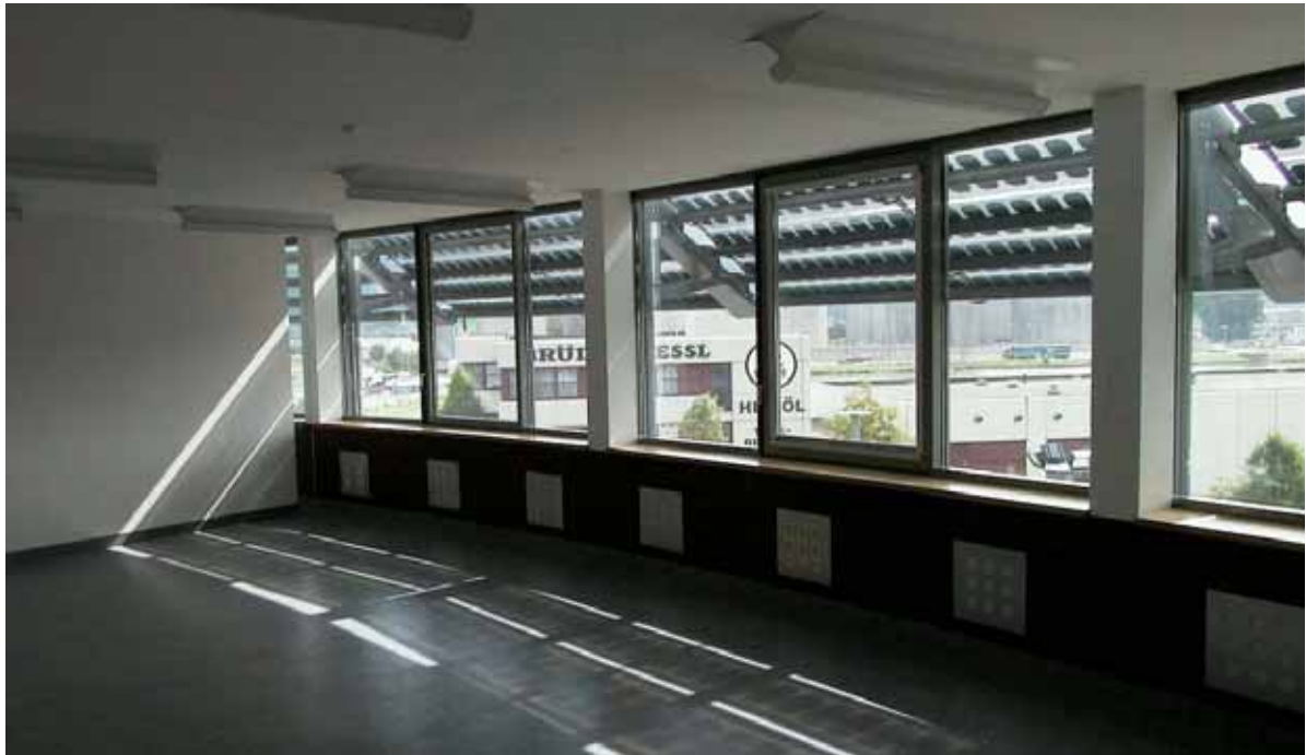
Abb. 24 PV-Beschattungsanlage mit thermohydraulischer Nachführung am SBL Linz von innen
