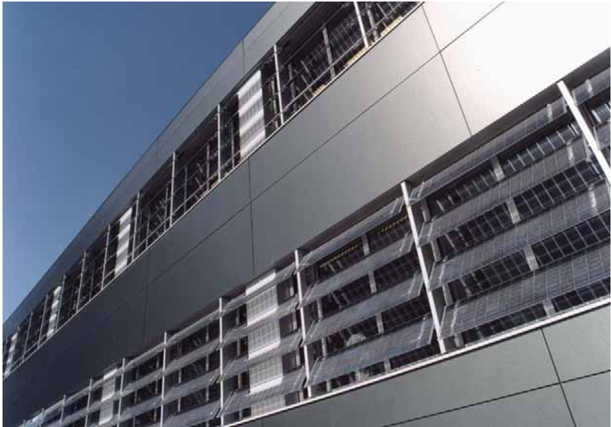
Abb. 22 Photovoltaikmodule vermögen auch konventionelle Sonnenschutzanlagen zu ersetzen
