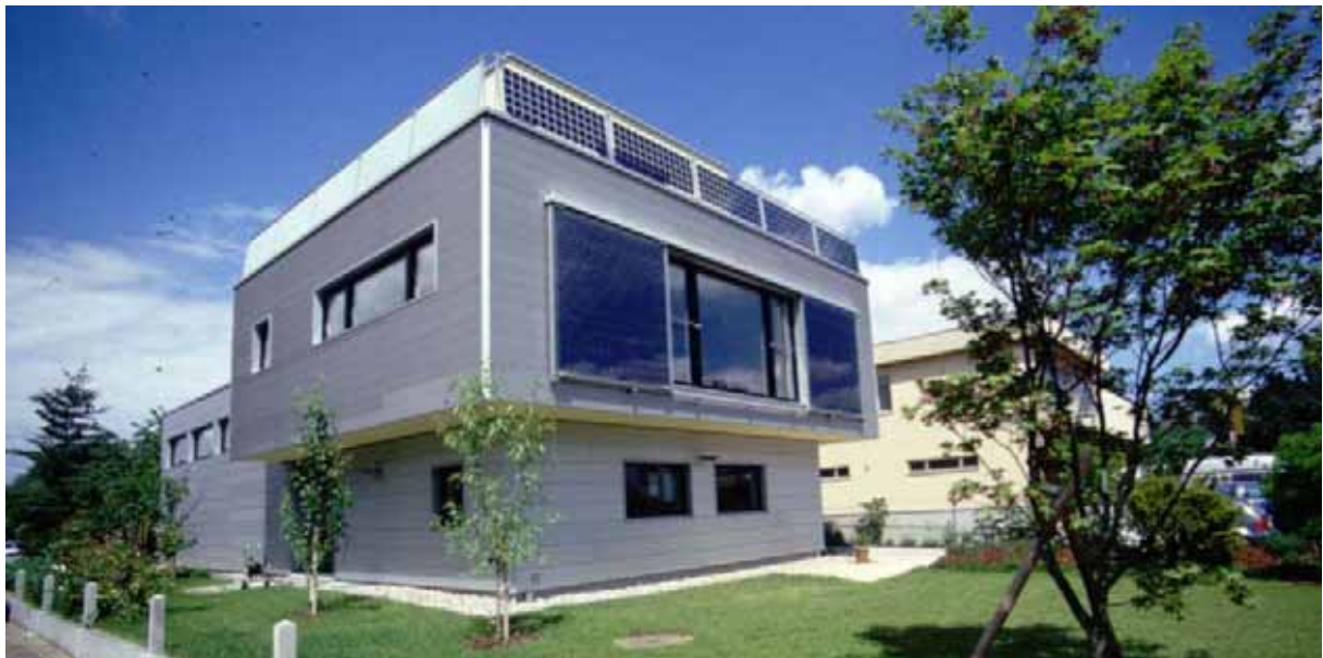
Abb. 25 Ansicht einer PV-Fassade mit integrierten Solarschiebeläden am Passivhaus Schmoelzer
