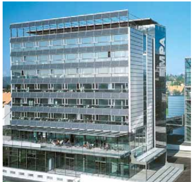
EMPA St. Gallen: Fassade VB Bild: Theo Hotz AG / EMPA
