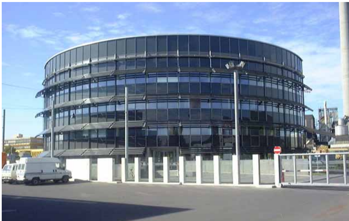
Abb. 23 PV-Beschattungsanlage mit thermohydraulischer Nachführung am SBL Linz von aussen
