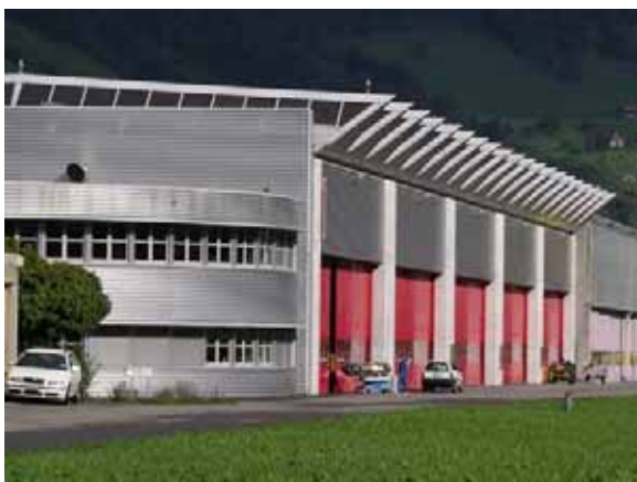
Flugplatz Alpnach: Sheds mit PV und Solarthermie Bild: Electrowatt Infra AG
