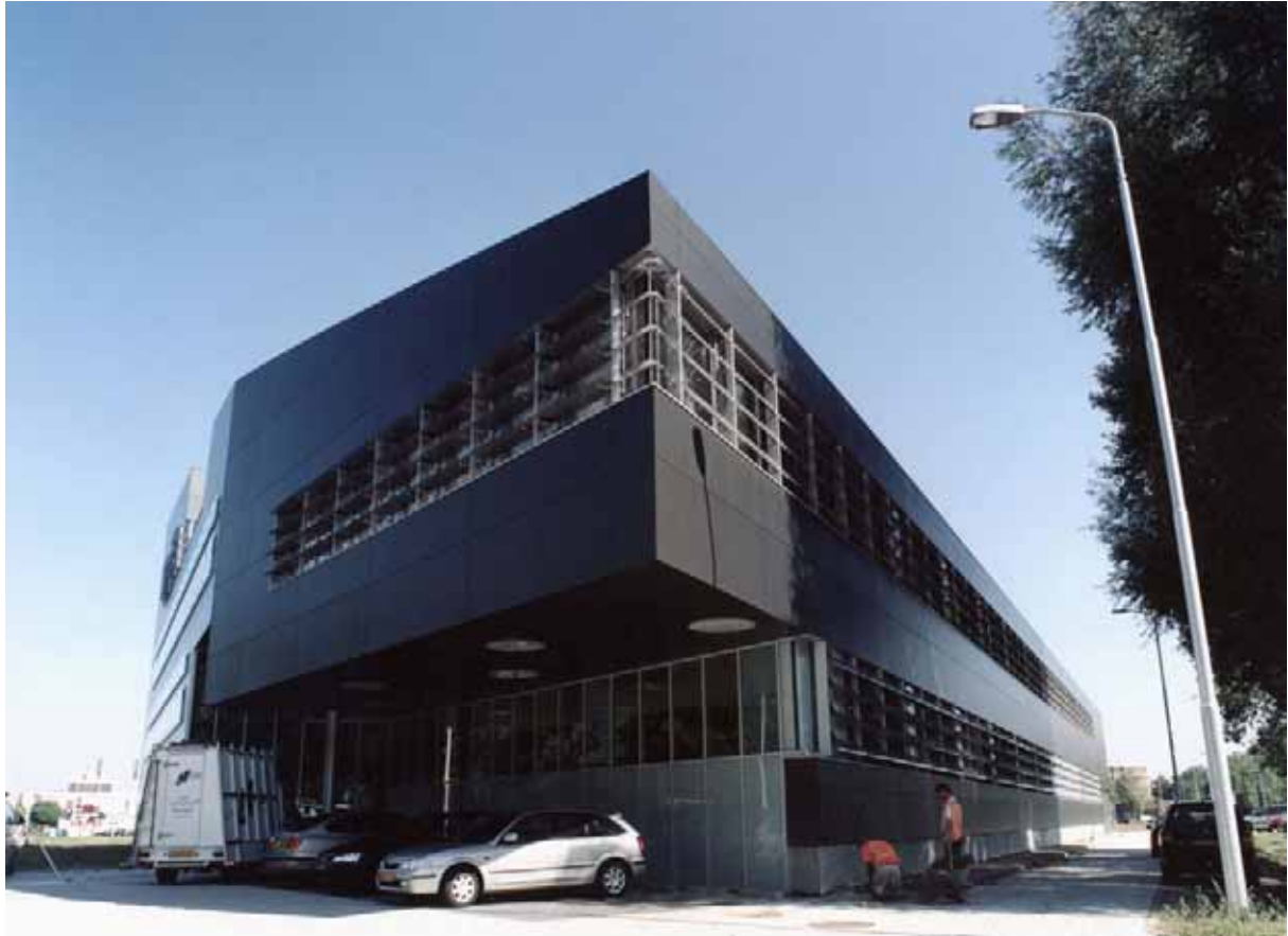
Abb. 21 Shadovoltaic an einem Bürogebäude der öffentlichen Verwaltung in Utrecht
