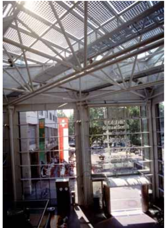
Abb. 9,10 Transluzide Photovoltaikgläser im Überkopf- und Durchsichtsbereich
