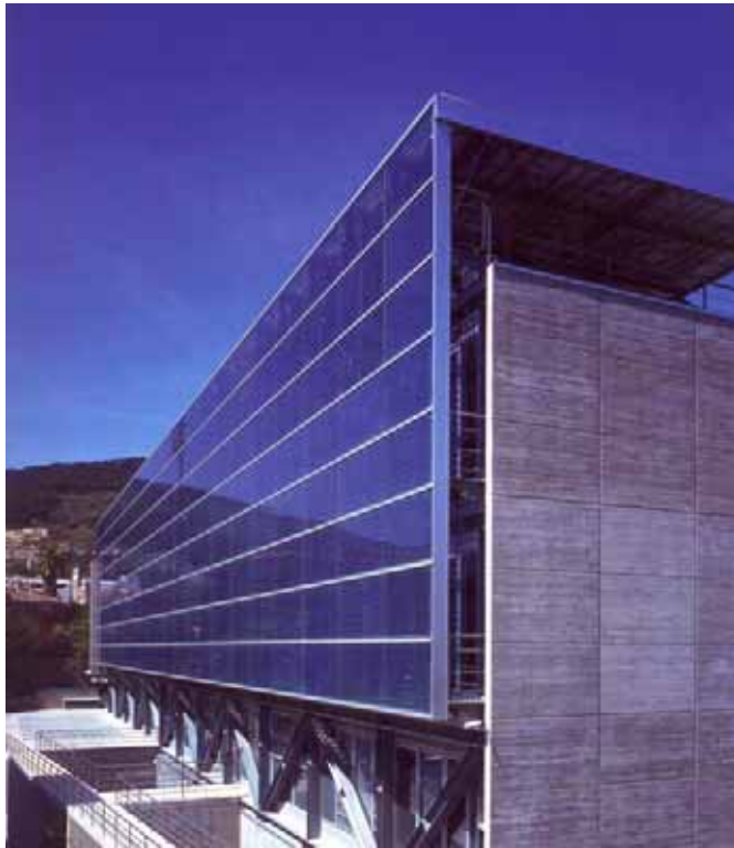
Abb. 9,10 Transluzide Photovoltaikgläser im Überkopf- und Durchsichtsbereich
