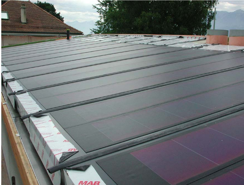
Fig.2 La toiture juste après pose des tôles solaires. Il ne reste plus qu'à enlever les feuilles de protection.
