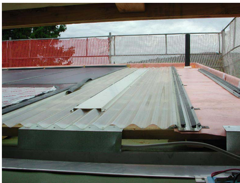
Fig.1 Détail avec le profilé et la sous-couverture étanche en feuille ondulée de polyester armé
