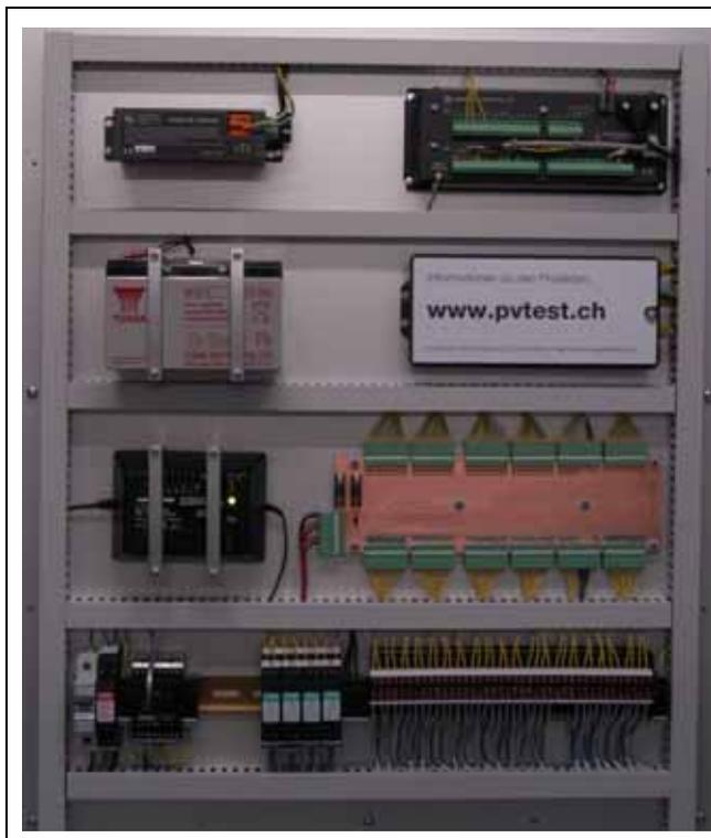
Abbildung 3-67: Tableau mit der Messdatenerfassung
