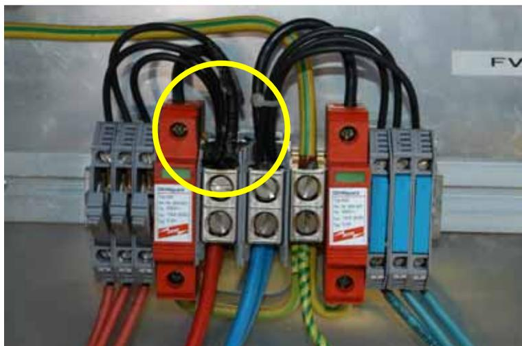
**Abbildung 4-15: Verschmolzene Litzen im Feldanschlusskasten**
