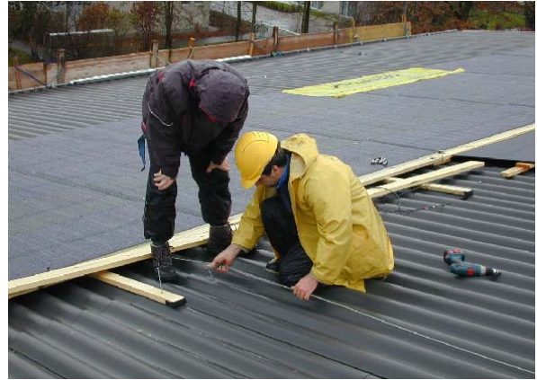
Figur 11: Vorbereiten der Unterkonstruktion
