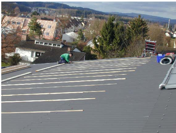
Figur 1: Lattenrost auf das bestehende Dach
