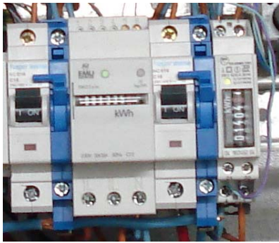
Figur 6: Energiezähler
