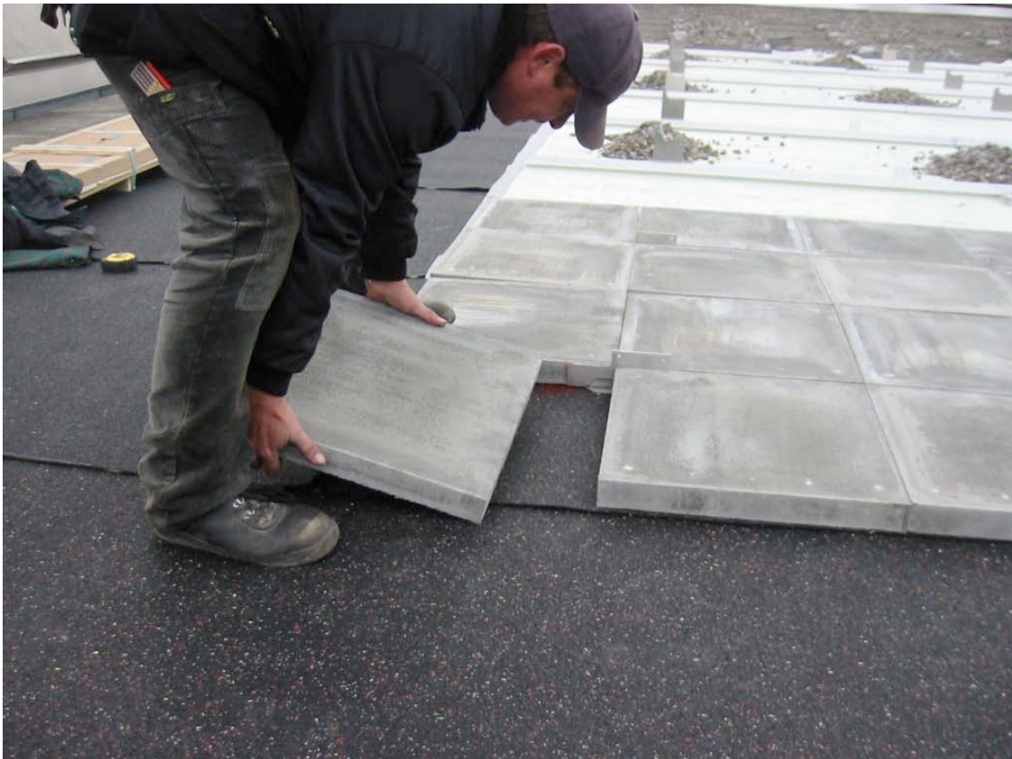
Bild 13. Das System SOLight-GW_PLATTEN wird mit handelsüblichen Gehwegplatten verlegt
