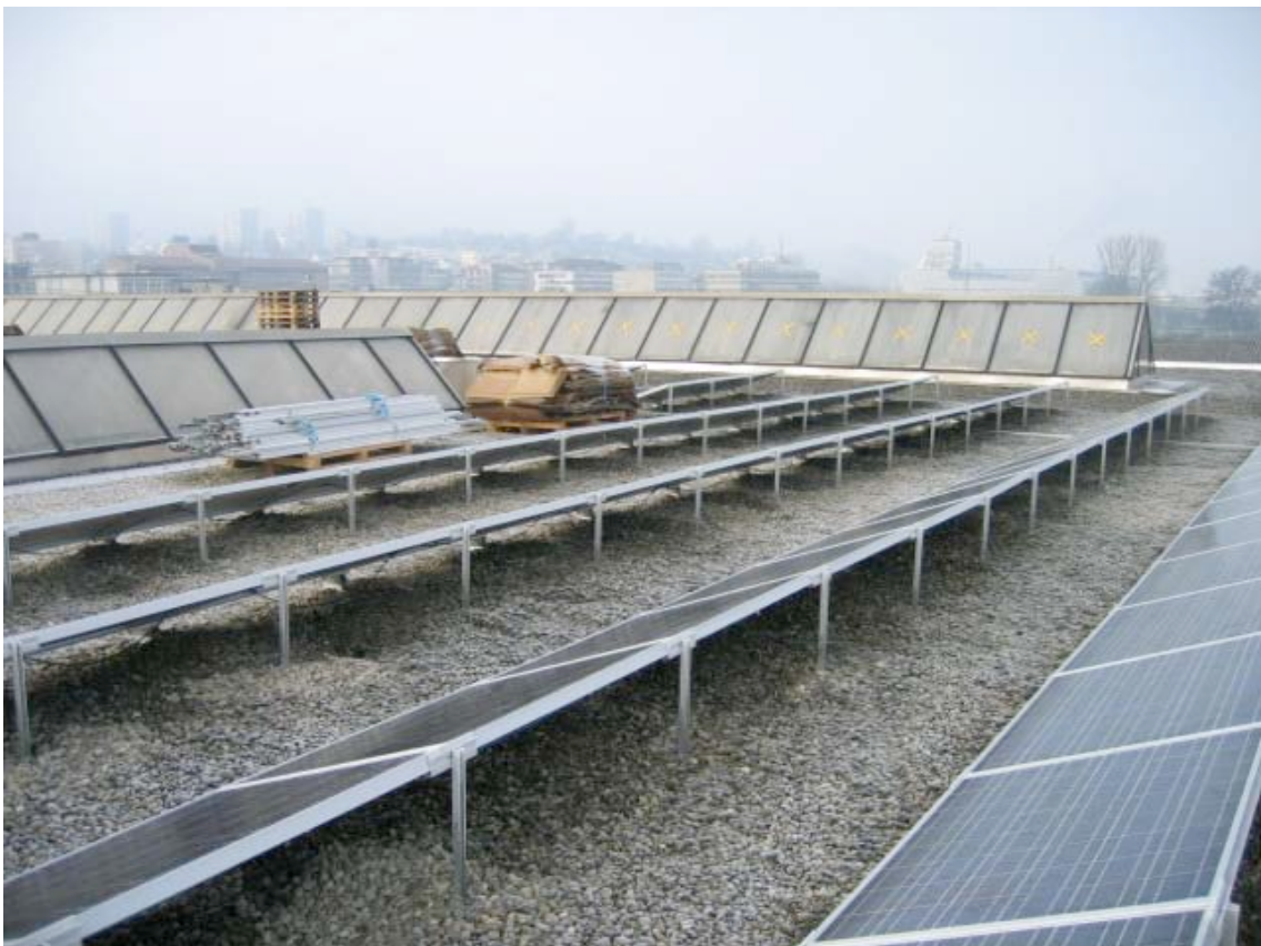
Bild 9. Die Module sind verlegt: Ansicht der Anlage von hinten.
