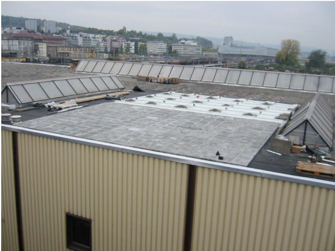
Bild 3. Gesamtansicht der P+D Anlage während dem Bau mit SOLight-GW-PLATTE (vorne) sowie SOLight-ROLLOUT hinten auf dem Dach der Egolf Verpackungs AG in Zürich
