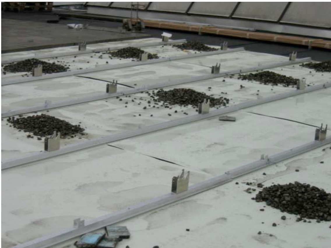
Bild 7. Vorbereitung der SOLight-ROLLOUT Folien auf dem Dach mit Teilen der Unterkonstruktion
