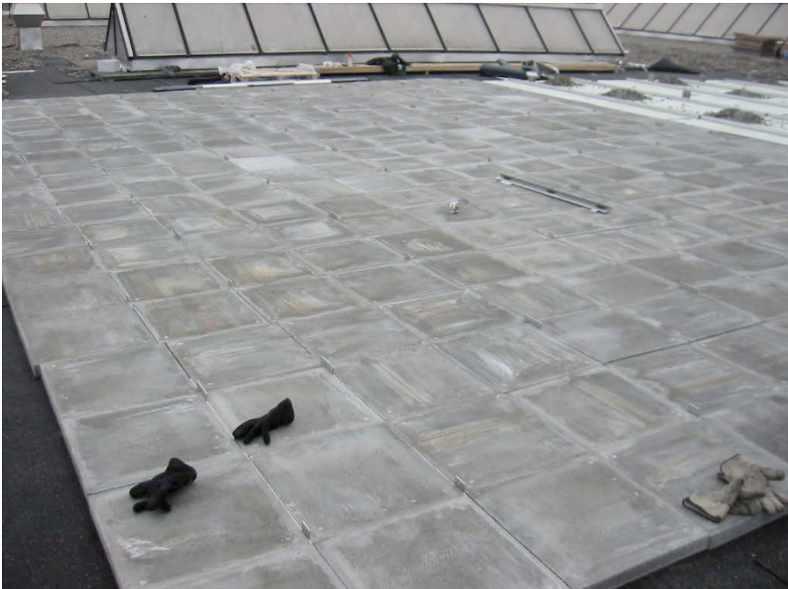
Bild 15. Vollständig verlegte SOLight-GW_PLATTEN mit Gehwegplatten
