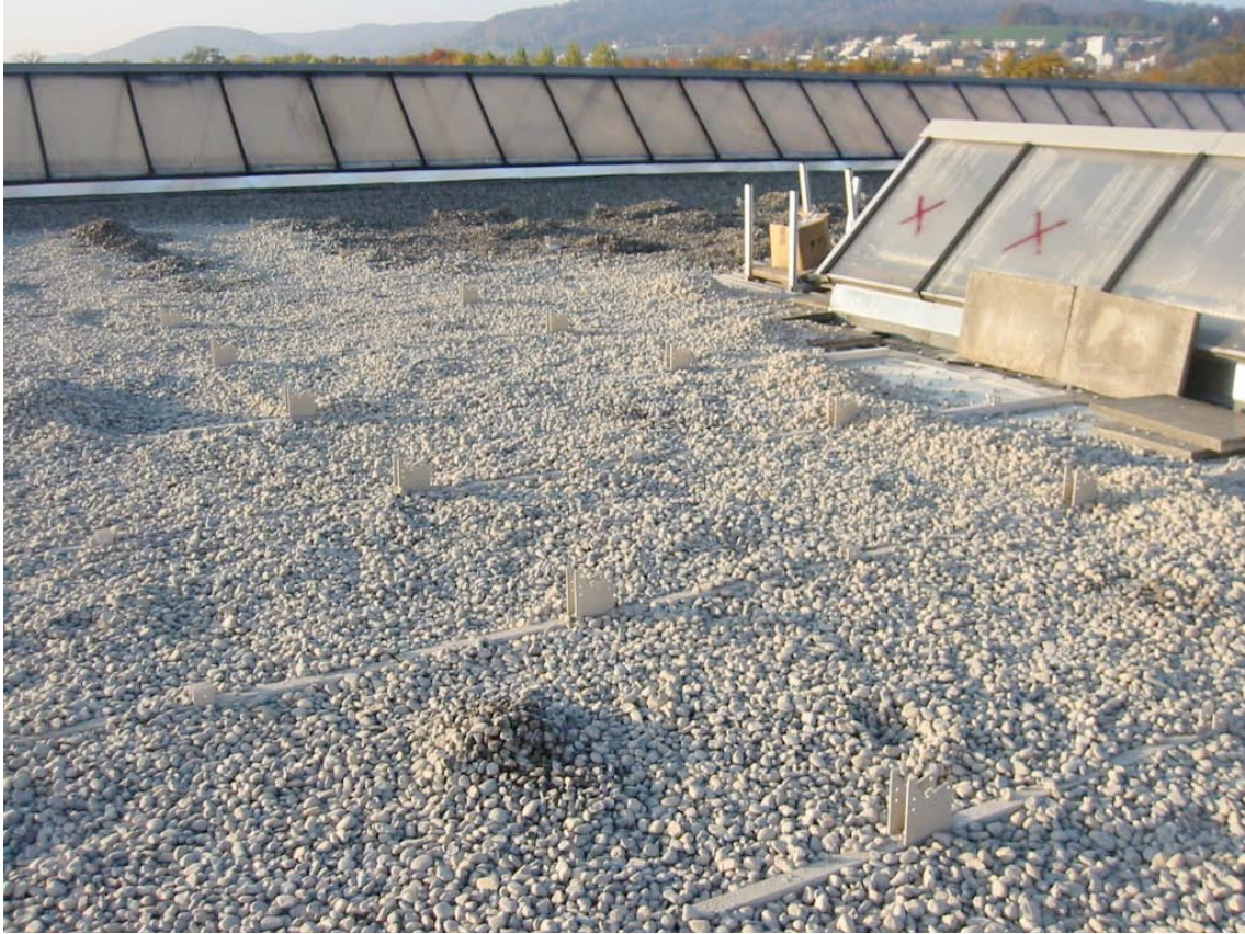
Bild 8. Das Kies wird verlegt und die Stützen schauen aus dem Kies hervor.
