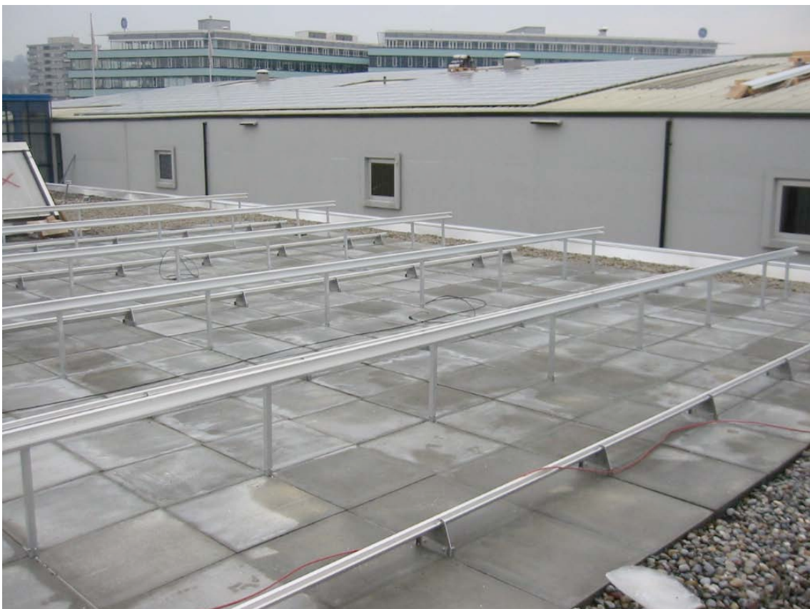
Bild 16. Unterkonstruktion fertig verlegt und bereit für die Montage mit Solarmodulen.
