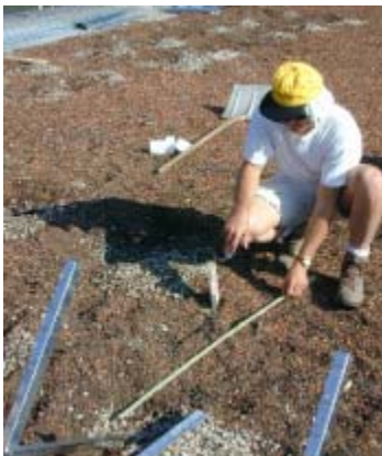
Abb. 10: Freilegen der Edelstahlplatten
