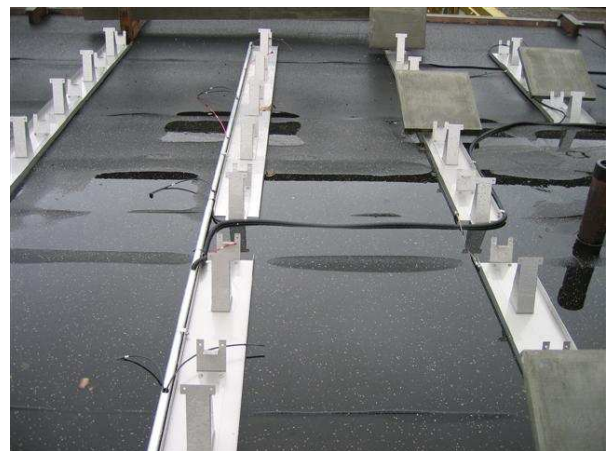
Bild 11: Unterkonstruktion und Verkabelung
