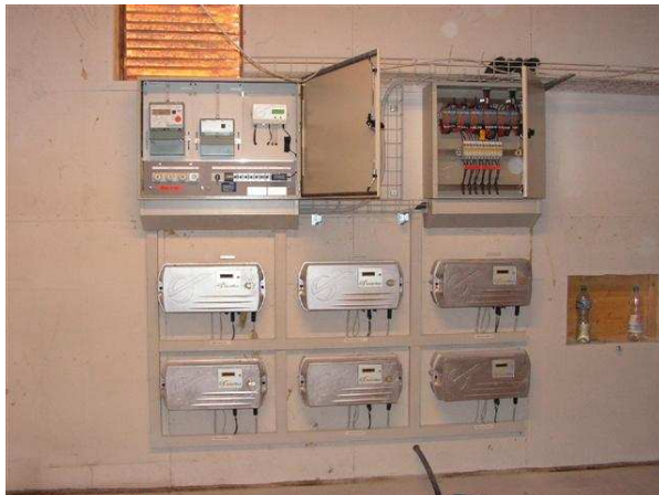
Bild 13: Wechselrichter / Elektroschränke
