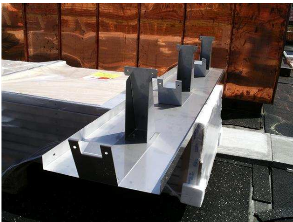
Bild 10: Aufbau Unterkonstruktion
