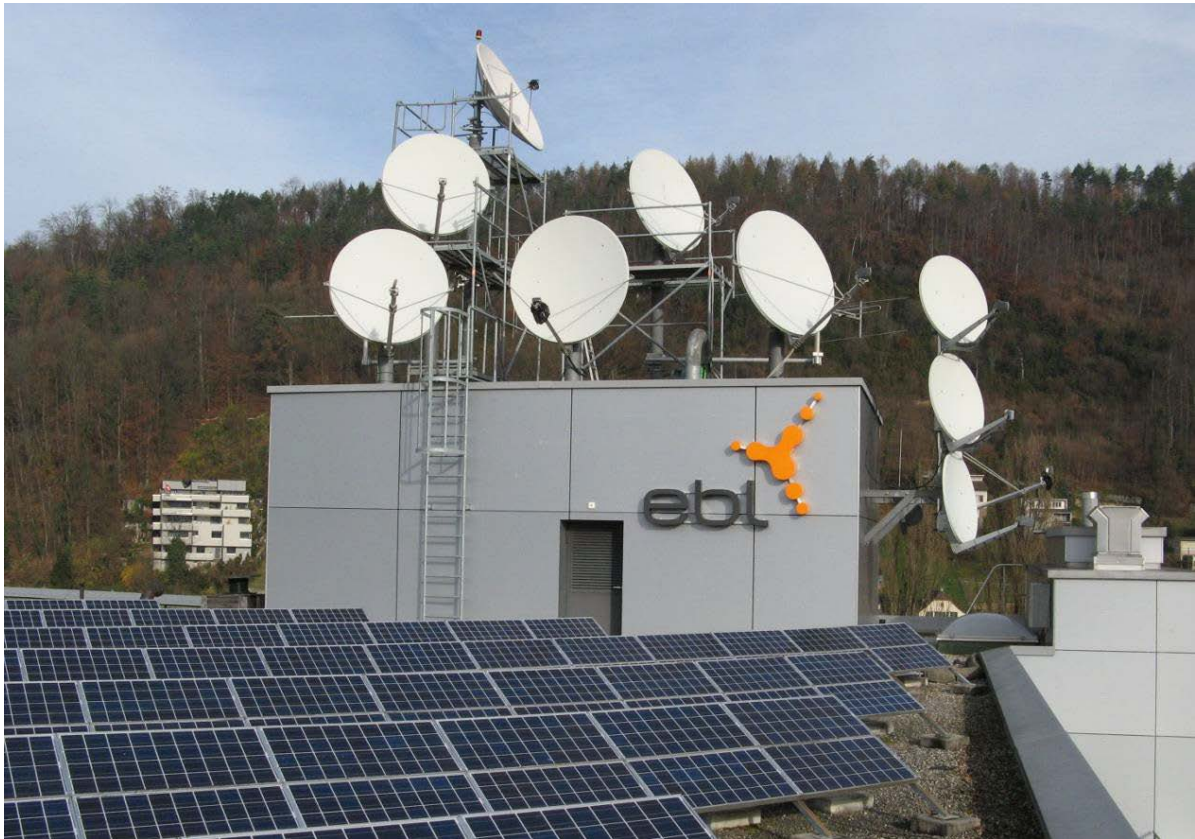
Abb. 3-10: Ansicht der Anlage EBL Liestal (wird seit Umbau am Morgen durch Antennen beschattet).
