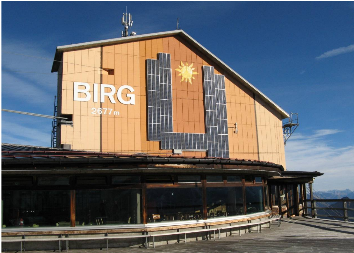
Abb. 3-4: Ansicht der PV-Anlage Birg an der Fassade der Mittelstation Birg der Schilthornbahn.
