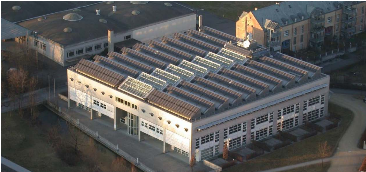
Abbildung 3-66: Ansicht des Solargenerators der Anlage Tiergarten in Burgdorf
