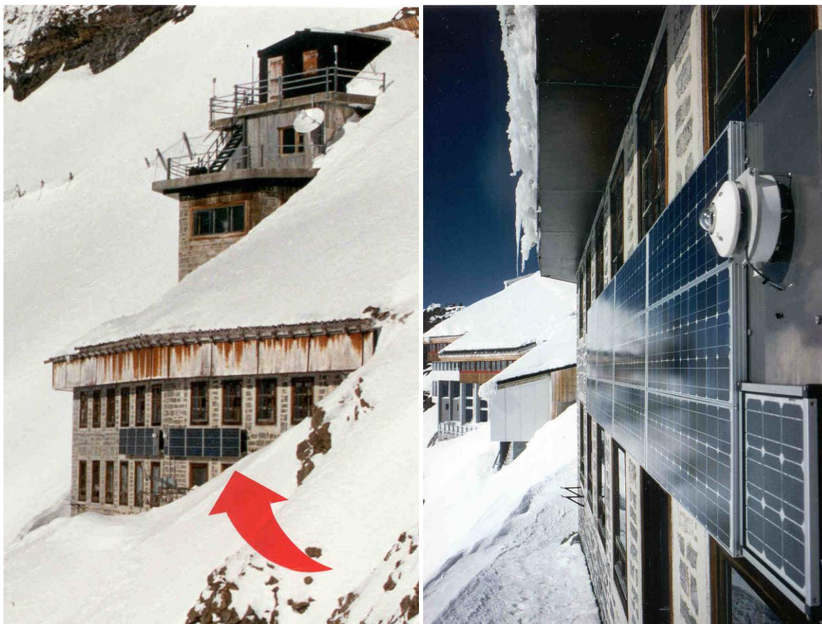
Abb. 3-23: Ansicht der PV-Anlage Jungfrauoch (1,13 kWp)
