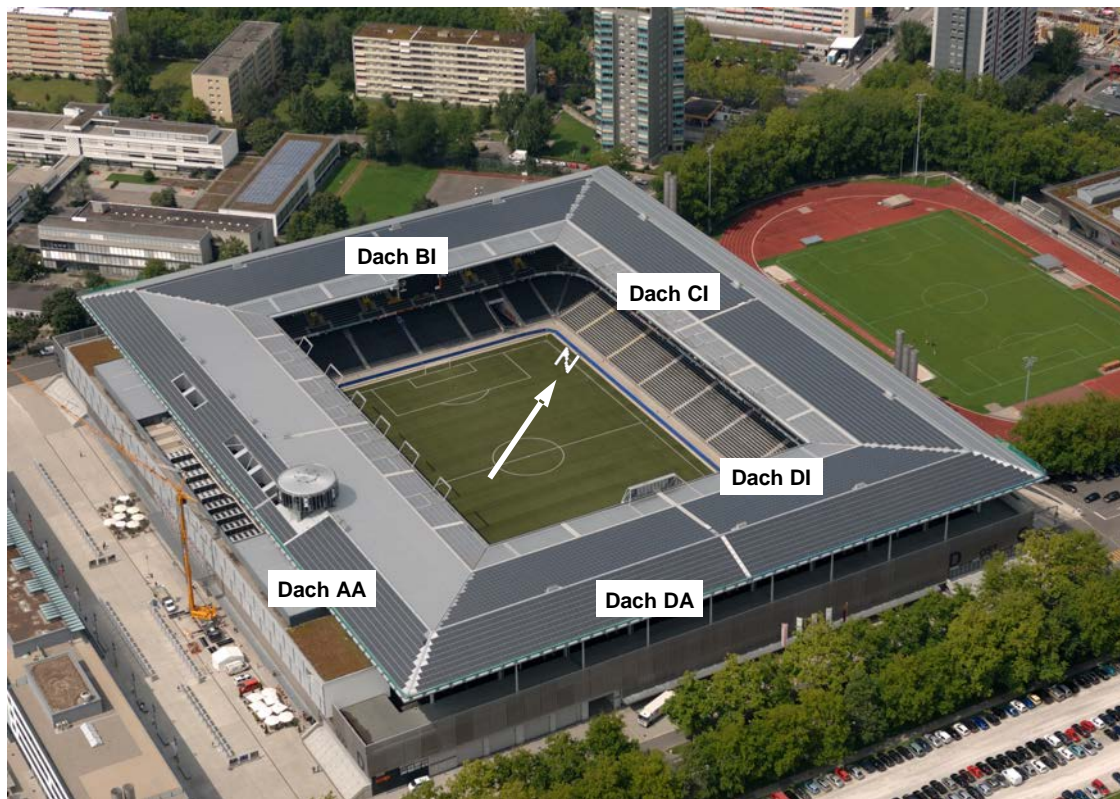
Abbildung 3-75: Luftaufnahme der Anlage nach dem Ausbau auf 1,34 MWp
