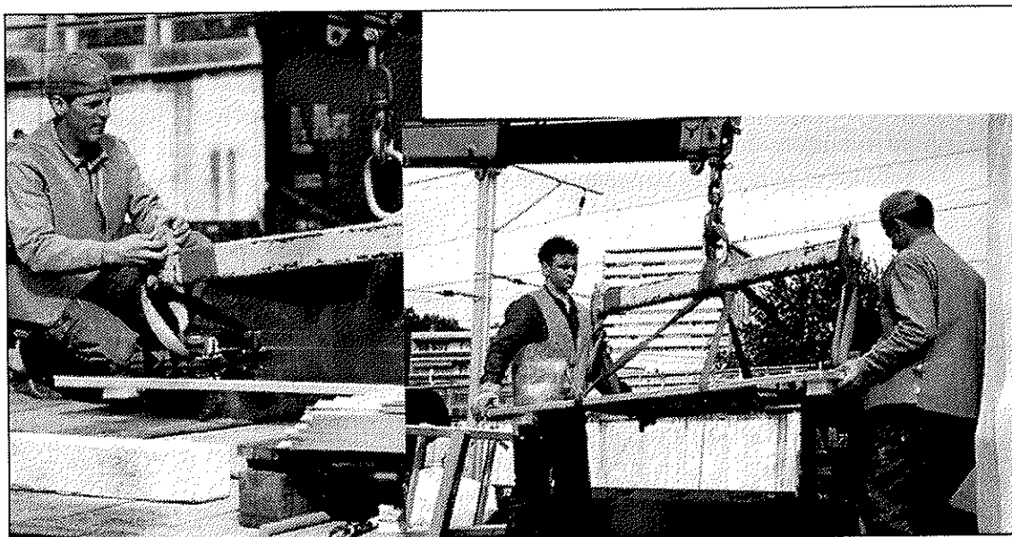
Figure 46 et 47 : système de fixation des modules par des sangles et des ventouses
