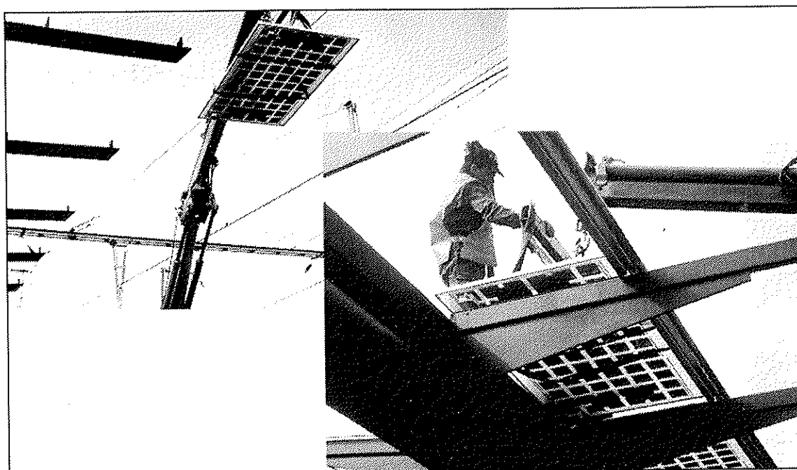
Figure 48 et 49 : transport des modules sur la marquise à l'aide d'une grue
