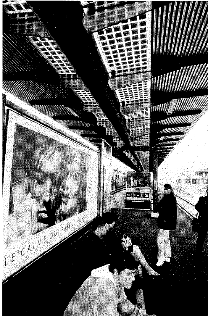
Figure 42 et 43: Vues de la marquise
