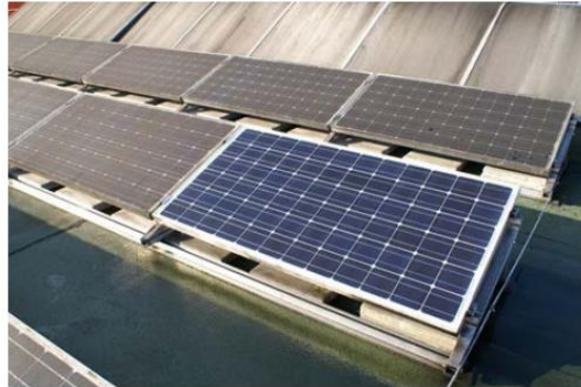
Abbildung 4.2.2 Pilzwachstum auf der Oberfläche von PV Modulen [34]
