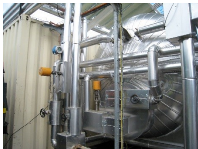
Vue de face de la cuve d'eau
