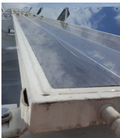
Figure 59 : Image rapprochée d'un capteur thermique effectuée en juillet 2016. Dépôts poussiéreux sur la surface vitrée du capteur.
