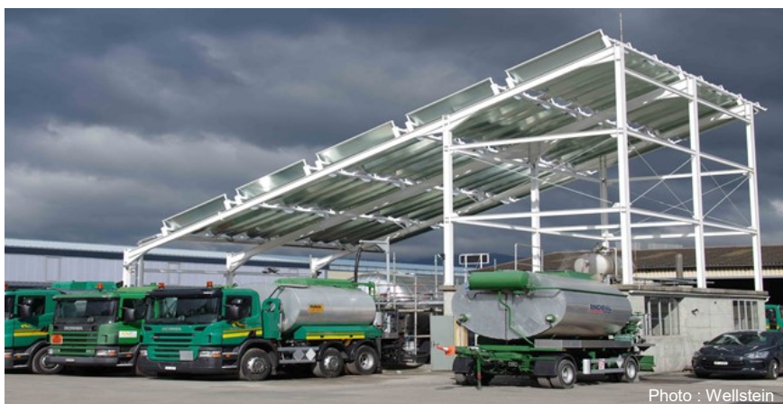
Figure 1 : Vue de l'installation Colas SA – site Pittet-Chatelan
