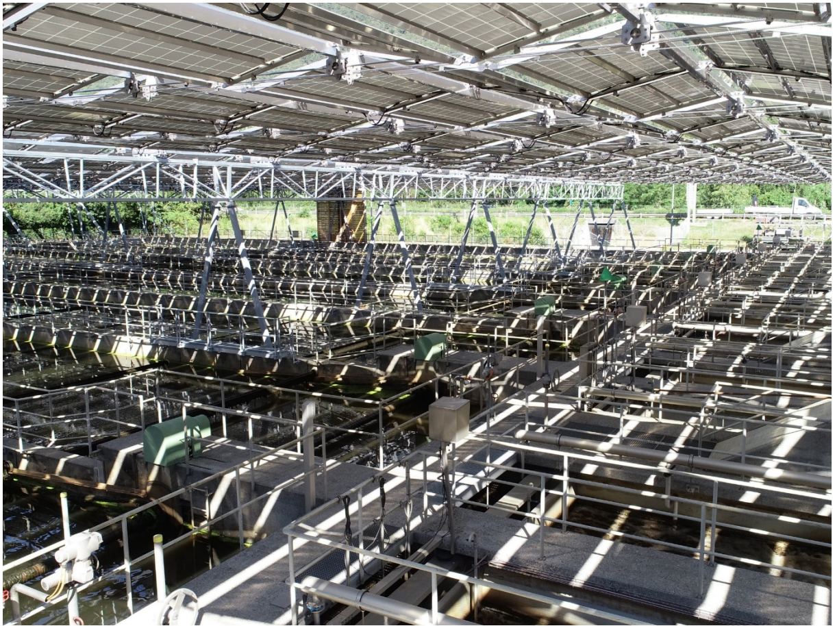
Abbildung 21 Beleungs- und Nachklärbecken ARA Chur mit Beschattung durch Solarfaltdach im Sommer 2018
