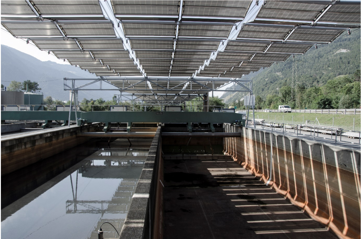
Abbildung 22 Entleertes Vorklärbecken (VKB) der ARA Chur in Revision und beschattet durch Solarfaltdach HORIZON im Herbst 2017
