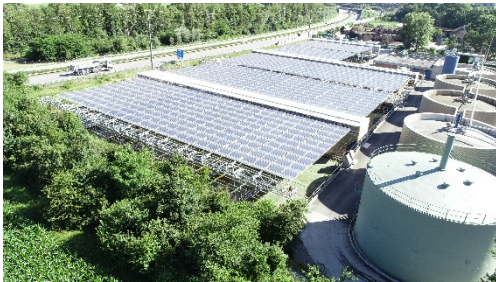
Abbildung 4 Solarstromproduktion. 2'120 kristalline Leichtbau-Solarmodule werden innerhalb von 60s mittels robuster Seilbahntechnik ein- oder ausgefahren.
