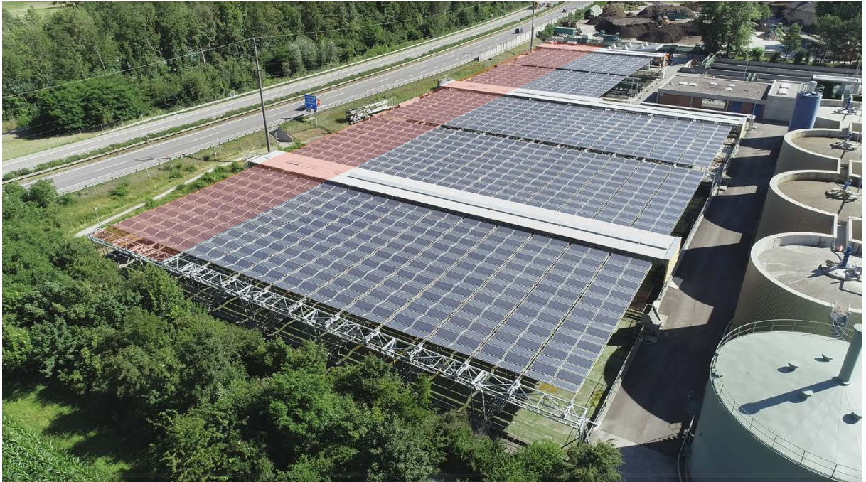
Abbildung 8 Solarfaltdach HORIZON mit 643kWp Leistung und 53 individuelle angesteuerten Faltdachgruppen der IBC Energie Wasser Chur auf der Abwasserreinigungsanlage ARA Chur (dhp technology AG), rot markiert: Phase 1 mit IBN September 2017
