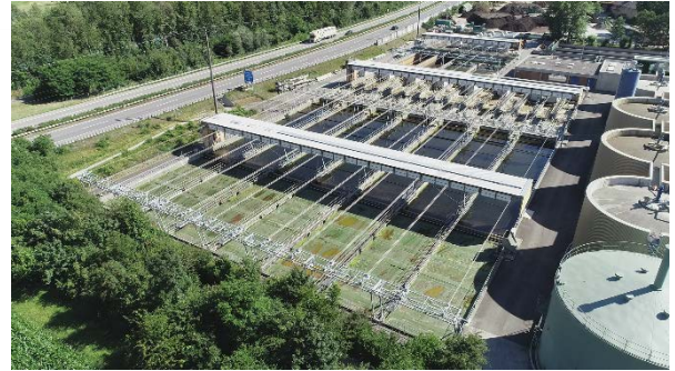
Abbildung 10 Module sicher aufgaragiert in Schutzposition bei Sturm, Hagel, Schneefall und wahlweise in der Nacht
