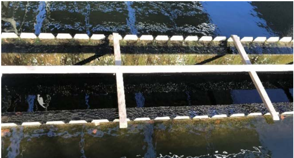
Abbildung 25 Überlaufkanal Nachklärbecken 1 mit Algenbildung, Randbecken
