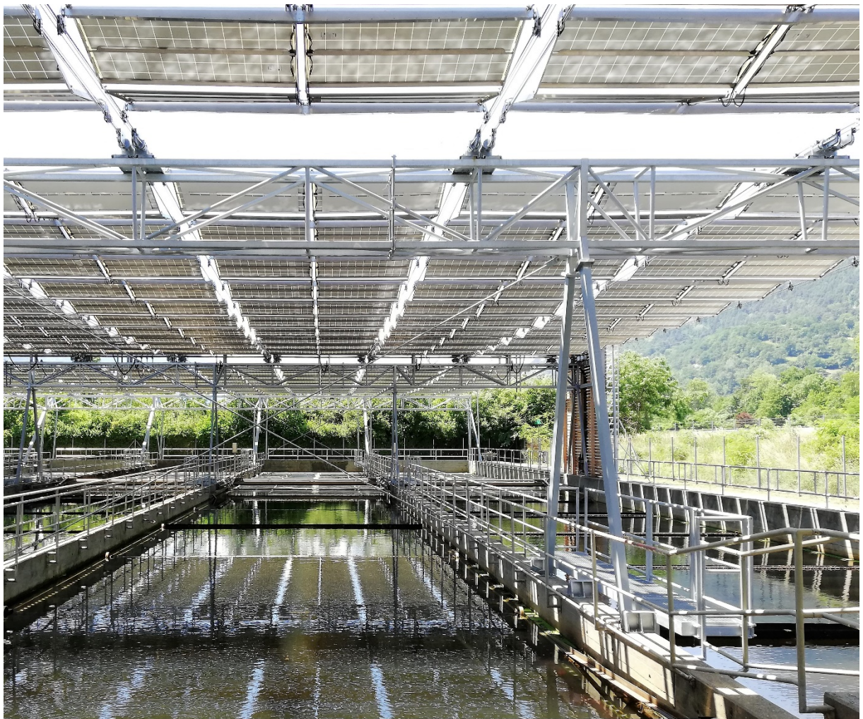
Abbildung 17 Solarfaltdach HORIZON ARA Chur: Stütze auf Beckenkronen mit Umgehungspodest für einfache Begehrbarkeit bei Kontrollgängen
