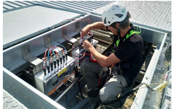
Abbildung 7 Einfacher Zugang zu Betriebsmitteln wie Generatoranschlusskästen und Antrieben
