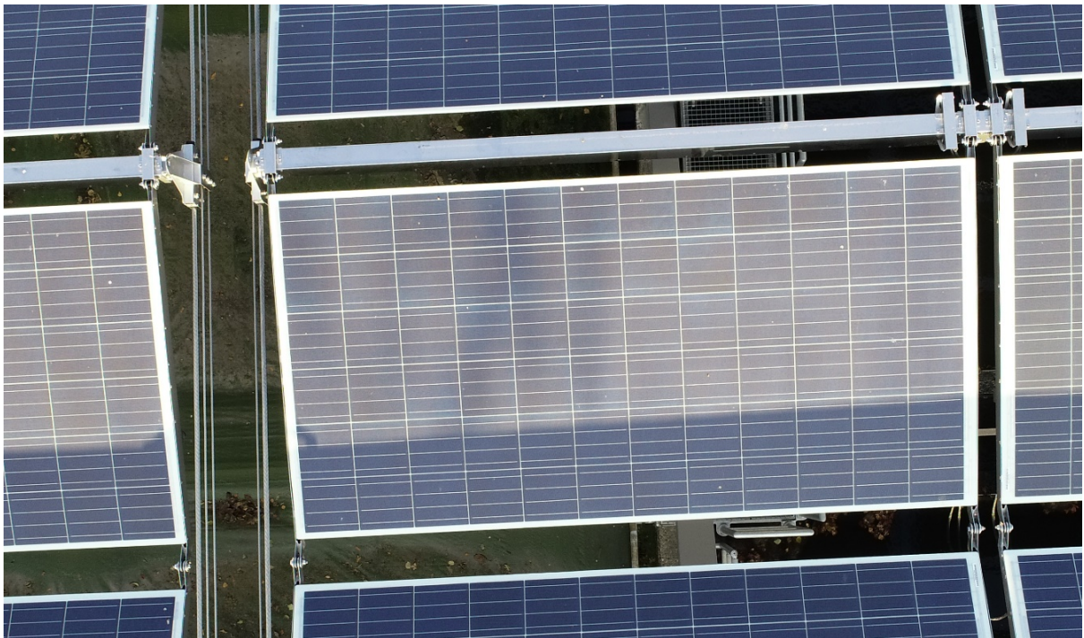
Abbildung 20 Vogelkot auf Moduloberfläche
