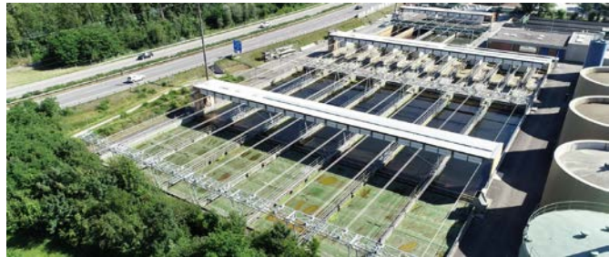
Abbildung 5 Faltdachgruppen garagiert in Schutzposition während Sturm, Hagel, Schneefall oder wahlweise in der Nacht.
