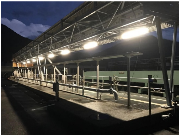
Abbildung 26 LEB-Beleuchtung an Tragwerk Solarfaltdach
