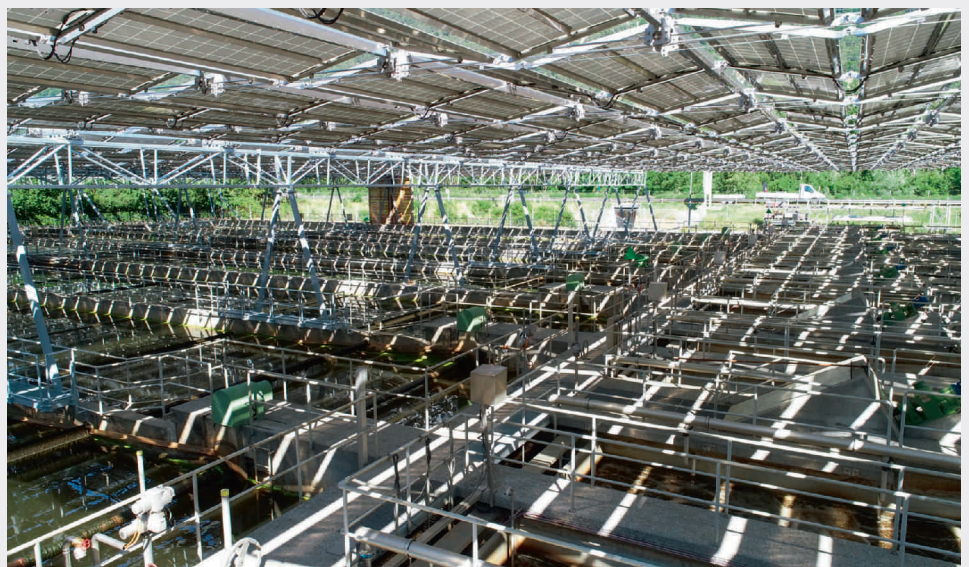
Fig. 5 Das Solarfaltdach über den Becken der ARA Chur kann jederzeit eingezogen werden.
