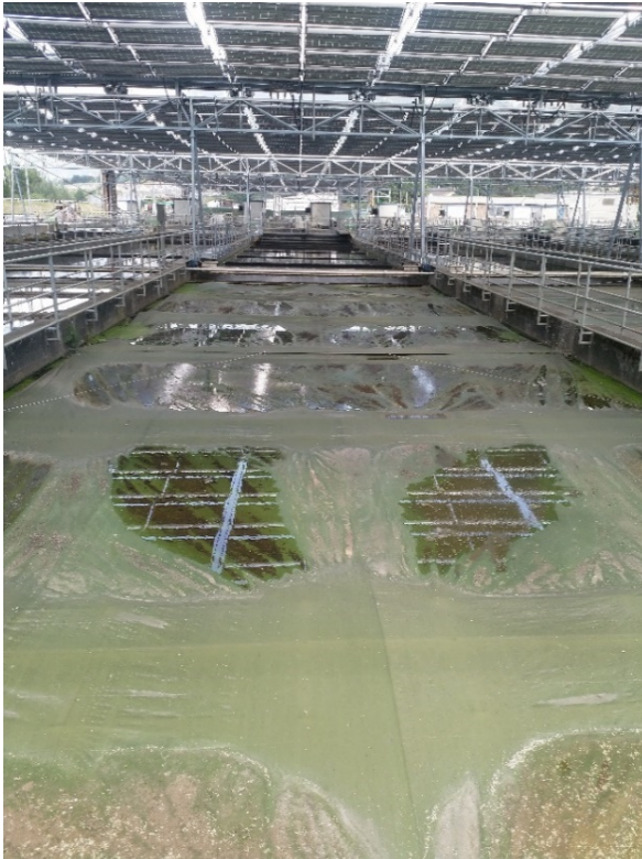
Abbildung 23 vollflächige Abdeckung des Nachklärbeckens (NKB), ARA Chur, Langzeiterfahrung und Nachweis Wirkung besteht
