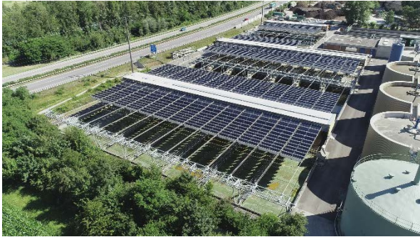
Abbildung 9 Das seilbasierte Solarfaltdach fährt die 2'120 glasfreien polykristallinen Leichtbaumodule (72 Zeller) innert 60s mittels robuster Seilbahntechnik in die Schutzposition
