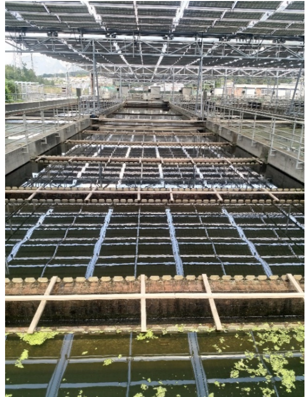
Abbildung 24 Abdeckung (NKB) auf 2 Bahnen entfernt, ARA Chur Ende Juli 2018, Verhalten Algenbildung unter Beobachtung
