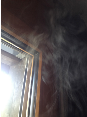
Abbildung 28 Leckage bei einem Fenster
