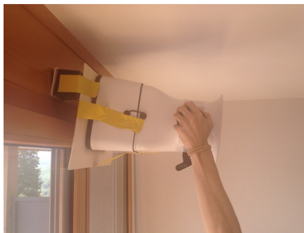
Abbildung 16: Messung des Luftvolumenstroms durch einen ALD mit dem Flow Finder
