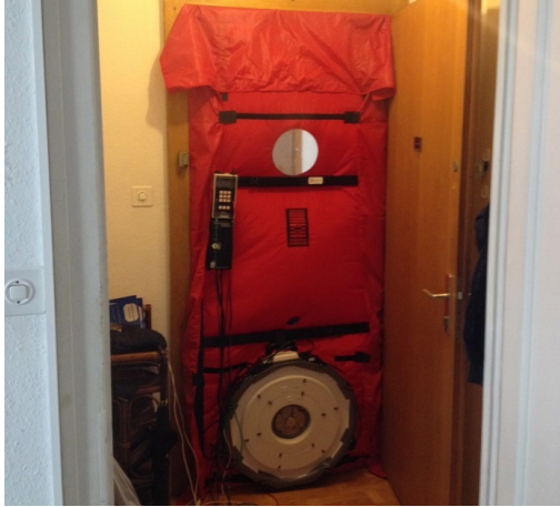
Abbildung 13: Installation Blower Door in Wohnungstür
