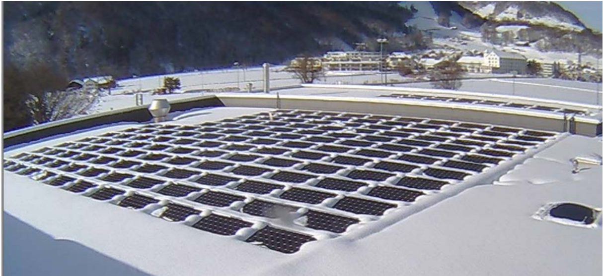
Abbildung 13: PVT-Module auf der linth-arena sgu am 17.01.2016: Schnee zwischen den Modulen führt zu Verschattungen.
