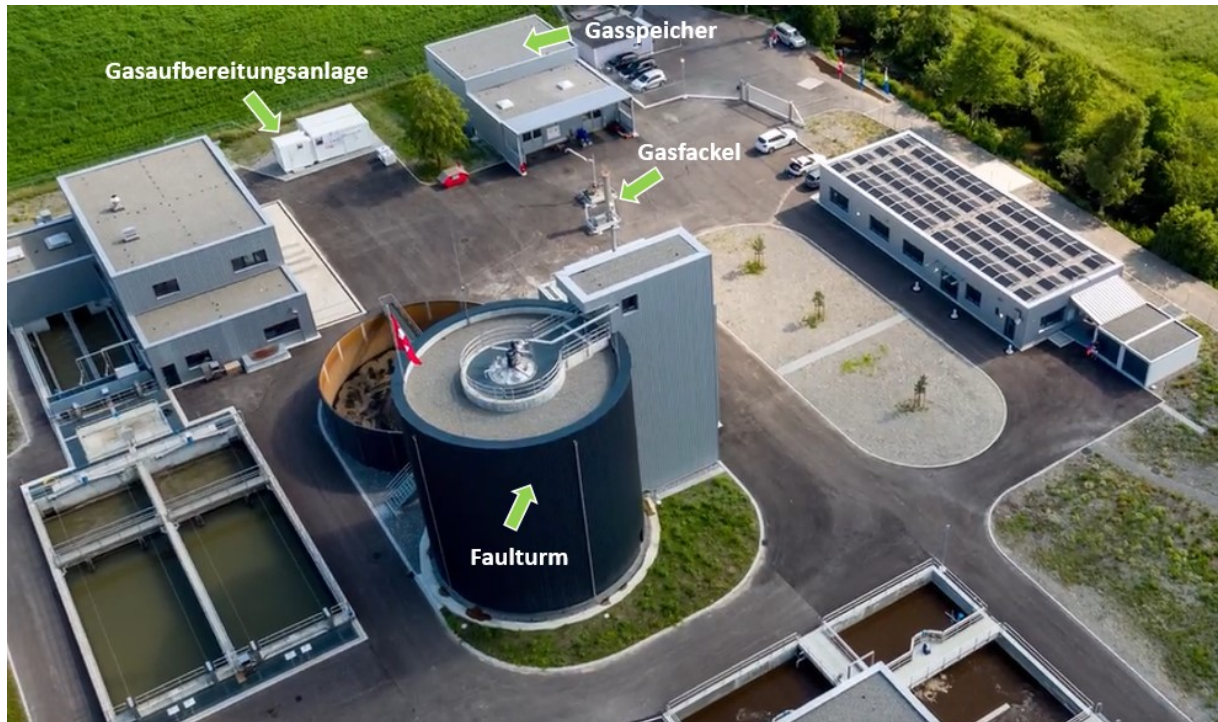
Abbildung 1: Aufsicht auf das Areal der ARA Reinach mit Blick auf die Komponenten Faulturm, Gasfackel, Gasspeicher und Gasaufbereitungsanlage.
