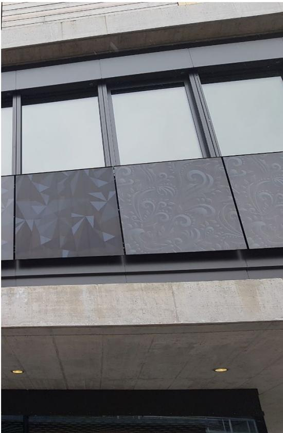
Bedruckte Photovoltaik-Elemente an der Meet2Create-Fassade. Foto: Empa
