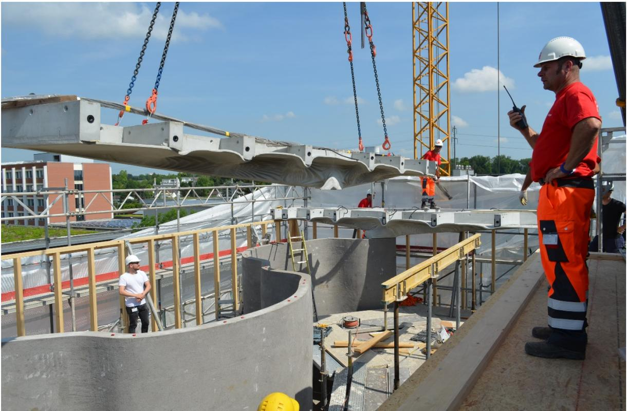
Installation von Smart Slab auf der Mesh-Mould-Wand. Foto: Empa
