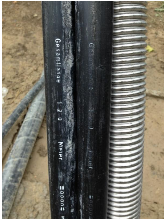
BILD 1 BILDER EINBAU CO 2 SONDE
