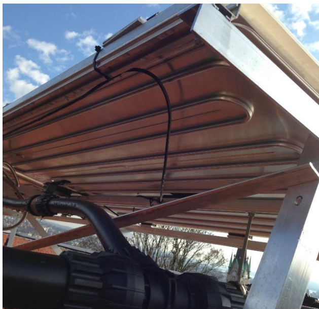
BILD 3 UNTERE ANSICHT HYBRIDKOLLEKTOREN
