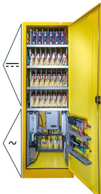
Abbildung 3: SL-Speicher mit Akkuzellen im oberen DC-Bereich und Wechselrichter und Steuerungen im unteren AC-Bereich
