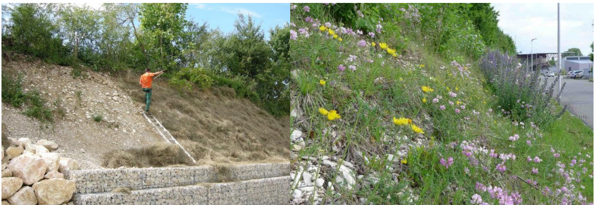
Abb. 9: Ansaat einer kiesigen Böschung mit Schnittgut eines Halbtrockenrasens. Fotos: Christoph Bühler.
