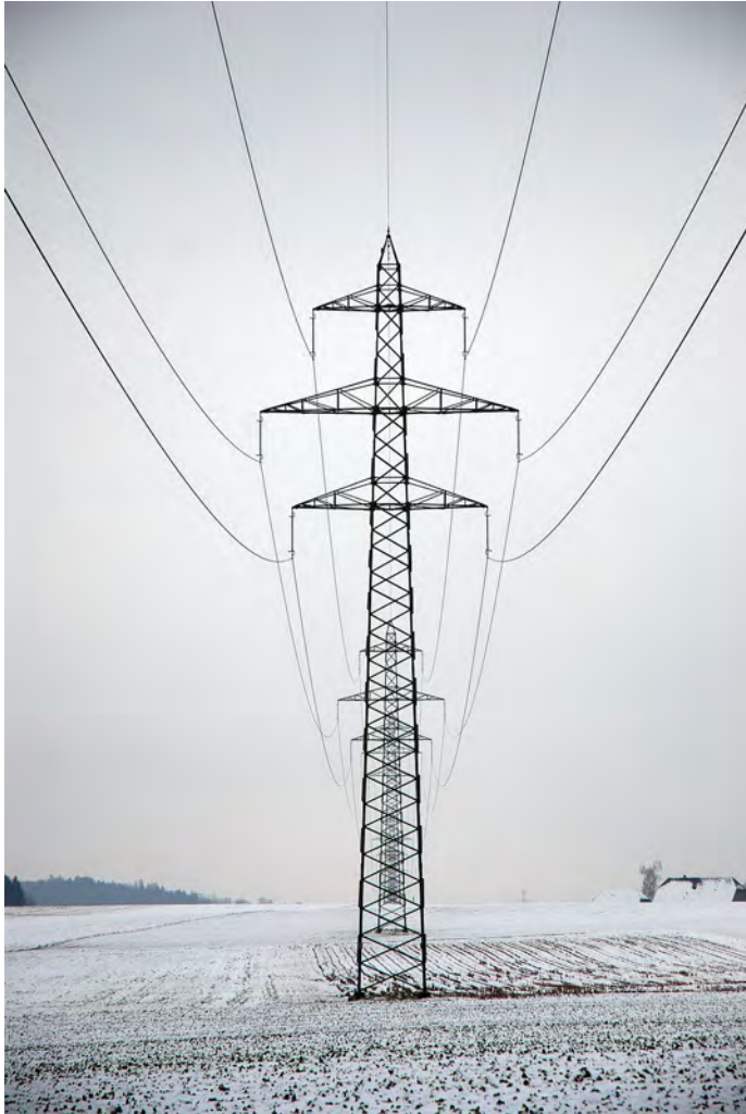
Abbildung 8: Bestimmen der Leitungssachse in Iffwil aus Masten in gerader Linie.
