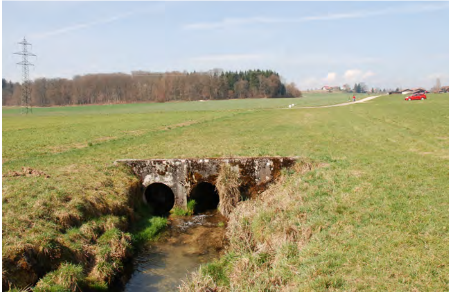
Abbildung 2: Austritt des Dorfbachs und der Drainageleitung aus der unterirdischen Leitung in Iffwil. Im Hintergrund rechts der Feldweg mit der Messstrecke.
